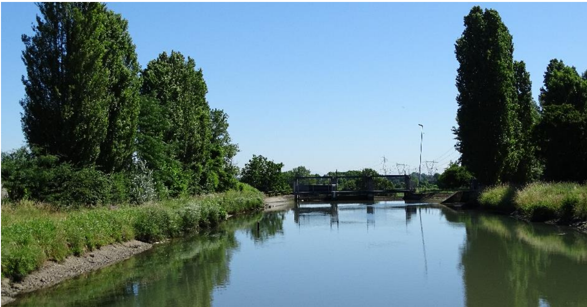
Figura 5.16: Vista del Canale Belgiardino (ad Est della Centrale)
