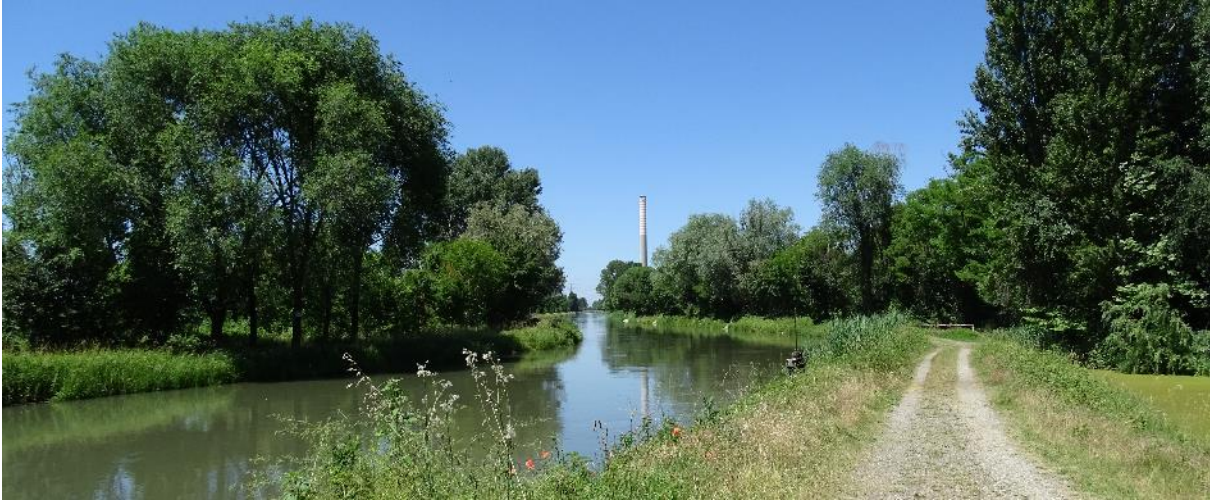
Figura 5.15: Vista del Canale Muzza (a Sud della Centrale)
