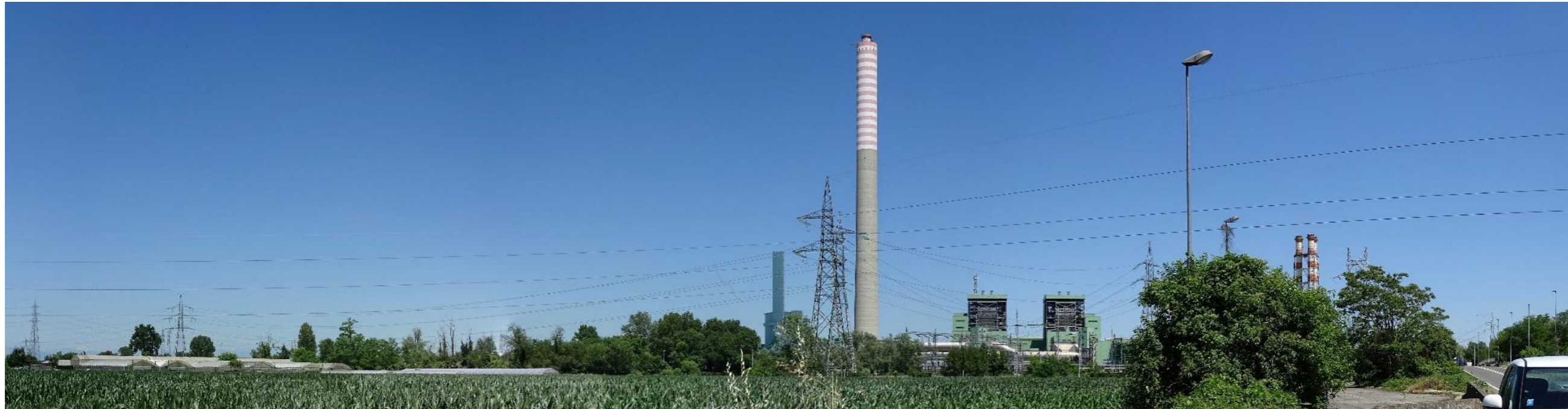
Figura 6.17: Vista dalla Rete Stradale Storica Via Emilia (03) – Fase 2
