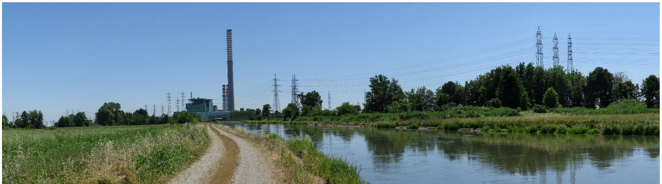
Figura 6.13: Vista dal Percorso di Fruizione Paesistica ed Ambientale Canale Muzza (02) – Fase 1
