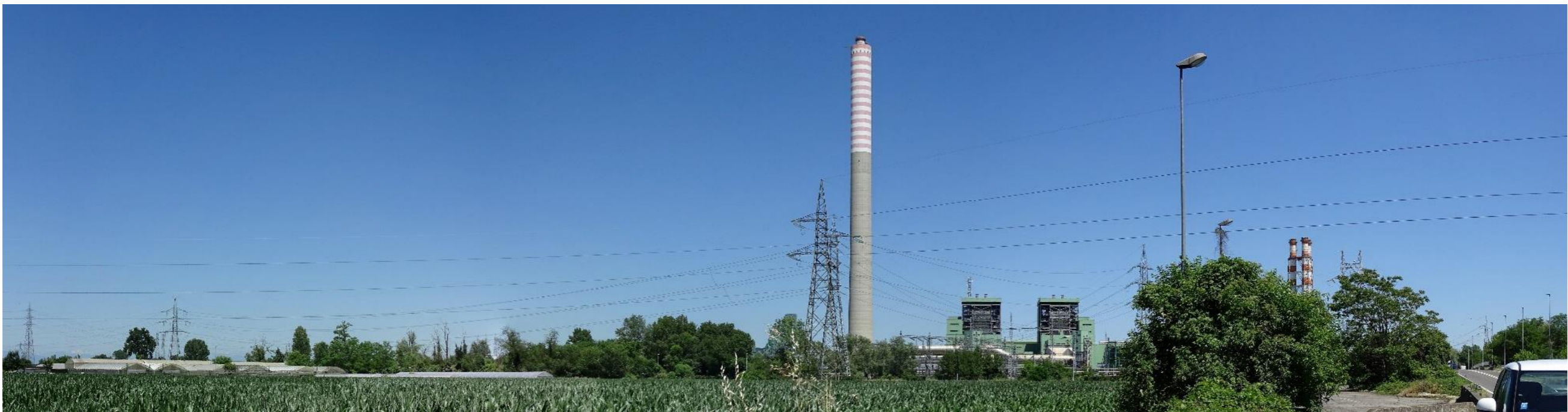
Figura 6.16: Vista dalla Rete Stradale Storica Via Emilia (03) – Fase 1
