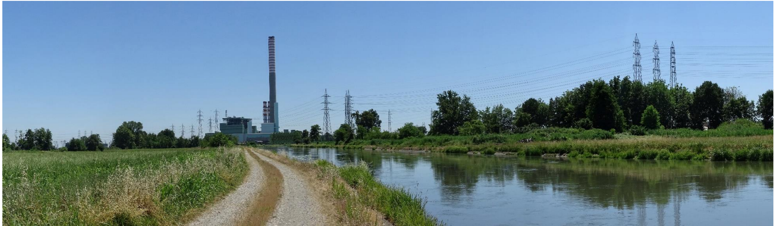
Figura 6.14: Vista dal Percorso di Fruizione Paesistica ed Ambientale Canale Muzza (02) – Fase 2
