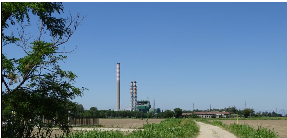
Figura 2.1: Vista della Centrale di Tavazzano e Montanaso
