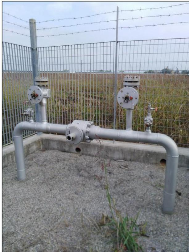
Immagine 4.2 - Esempio piping impianto di intercettazione di linea
