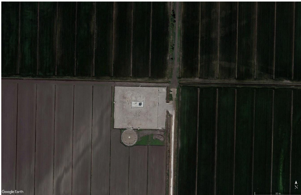
Figura 9: Piazzola utilizzata per Trava#2dir che servirà per Trava#3dir/Trava 2dir drilling pad to be used for Trava 3dir well also.
