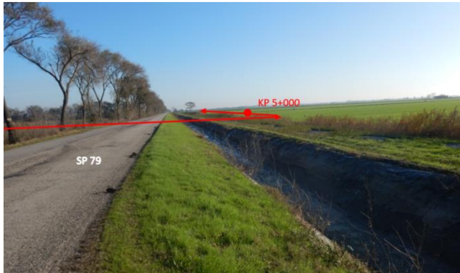
Figura 5.l: Fase 1 – Metanodotto – Ripresa Fotografica in Prossimità del KP 5 (Attraversamento SP 79 e Canaletta)
