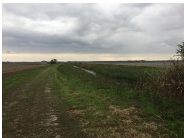
Figura 6.h: Canale Secondario Mondo Nuovo attraversato dal tracciato del metanodotto
