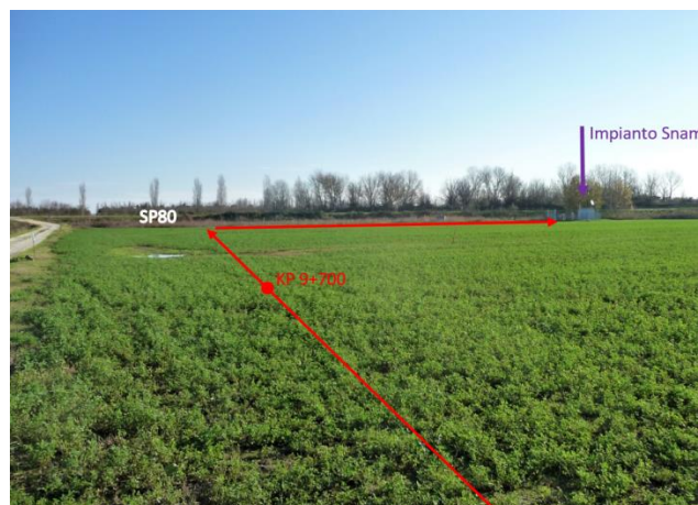
Figura 6.m: Arrivo del metanodotto alla stazione di consegna/misura
