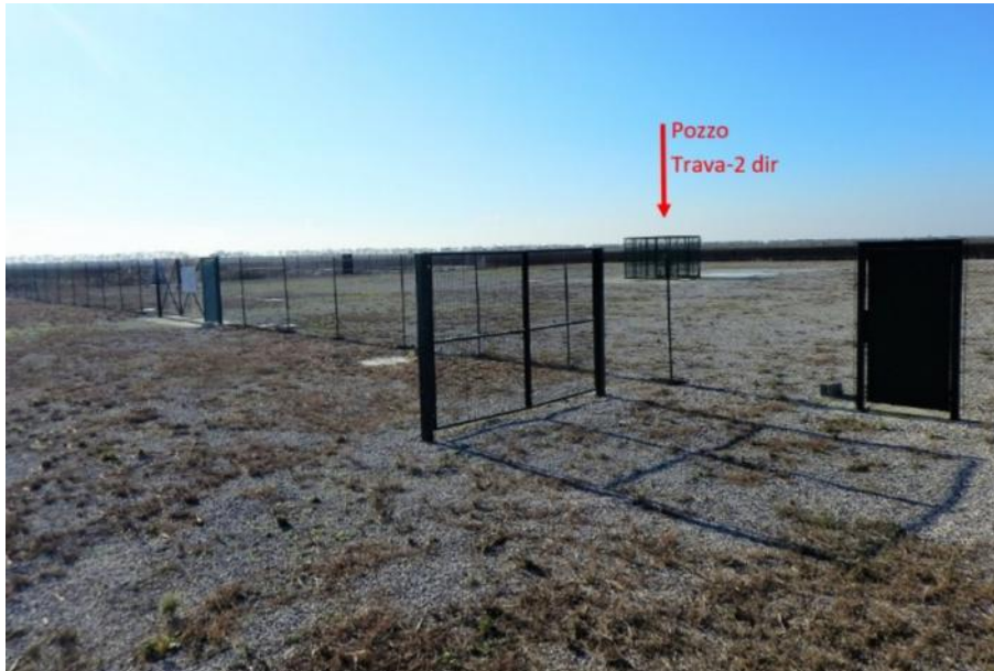
Figura 5.b: Fase 1- Area Pozzo Trava-3 dir, Ripresa Fotografica di Dettaglio Area Pozzo Trava-2 dir (Esistente)
