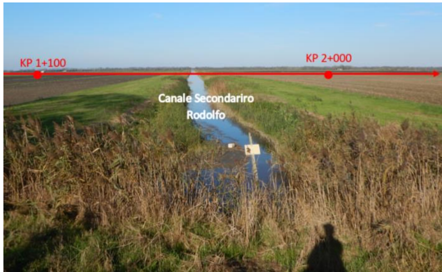
Figura 5.k: Fase 1 – Metanodotto – Ripresa Fotografica tra KP 1 e KP 2 (Attraversamento Canale Consortile)
