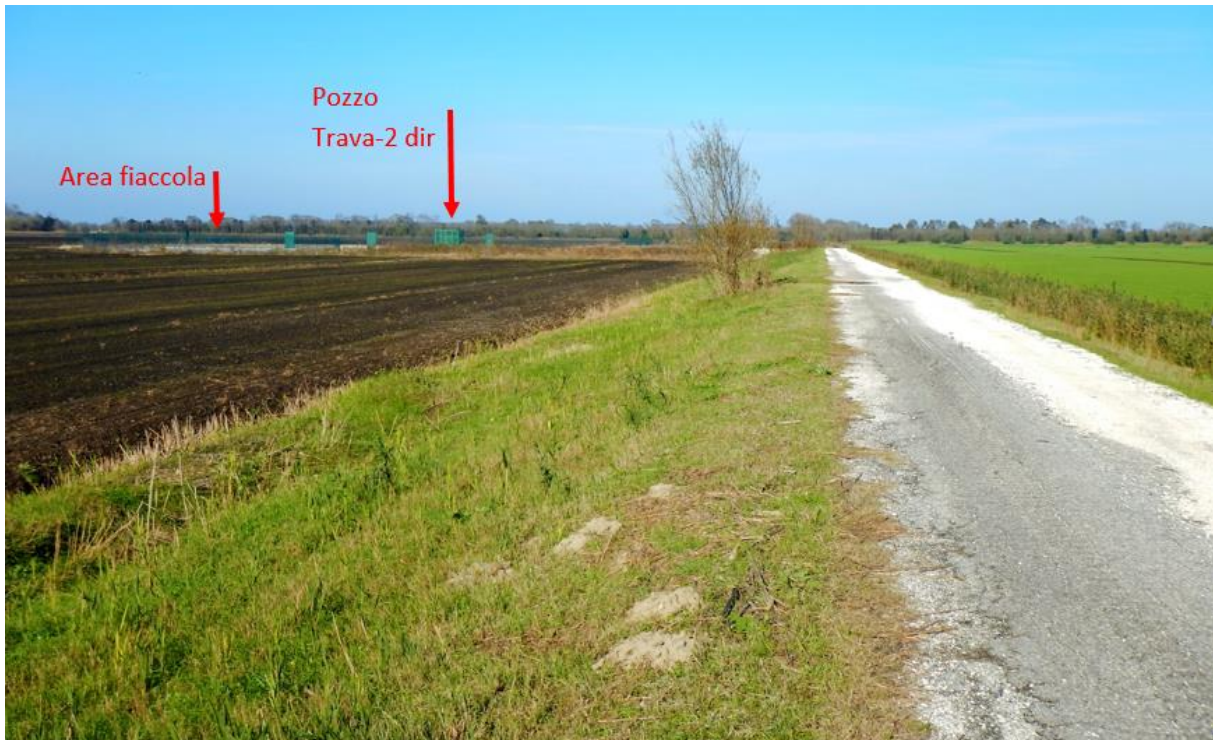
Figura 5.g: Strada di Accesso all'Area Pozzo Trava 2 dir/3 dir
