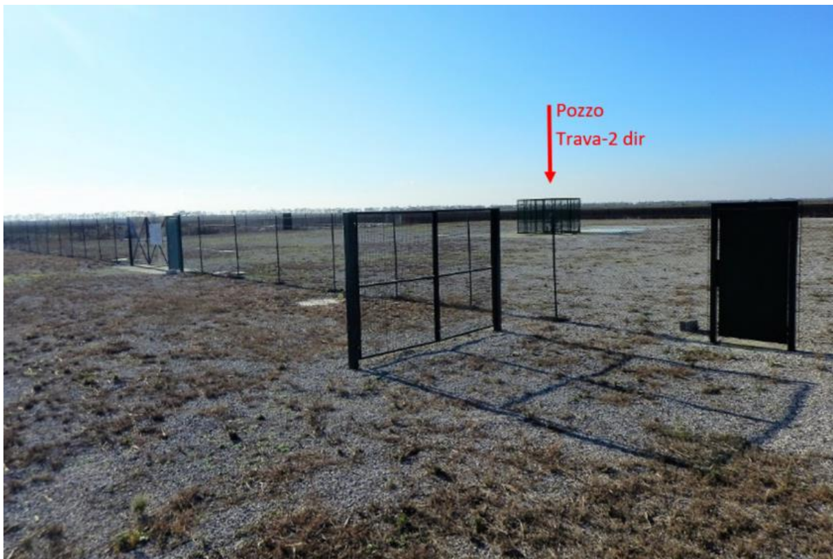
Figura 4.a: Fase 1- Area Pozzo Trava-3 dir, Ripresa Fotografica di Dettaglio Area Pozzo Trava-2 dir (Esistente)
