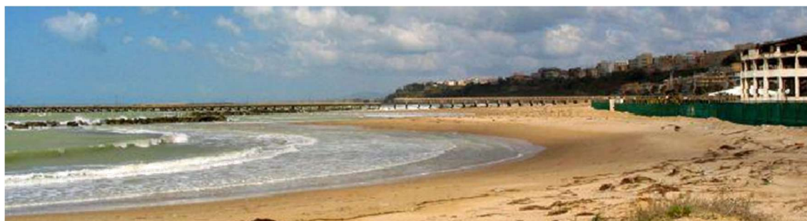
Figura 3.2/9. Vista del pontile sbarcatoio
