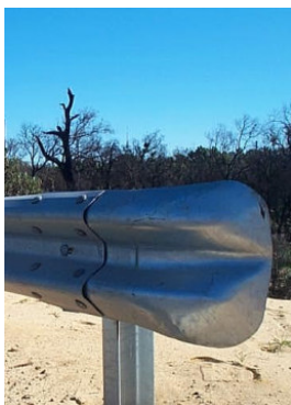
Figura 3: elemento terminale di fine impianto (tradizionale “a manina” non ammesso in progetto a sx e soluzione prevista in PE a dx)
