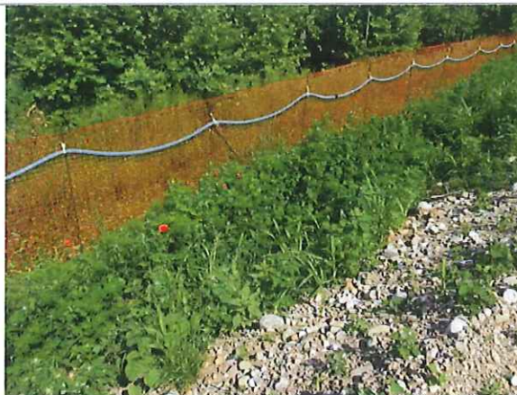
Dettaglio duna A3-4 sul lato ovest del cantiere
