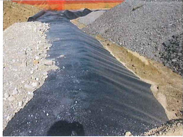
Dettaglio del telo di impermeabilizzazione del cumulo A4-2
