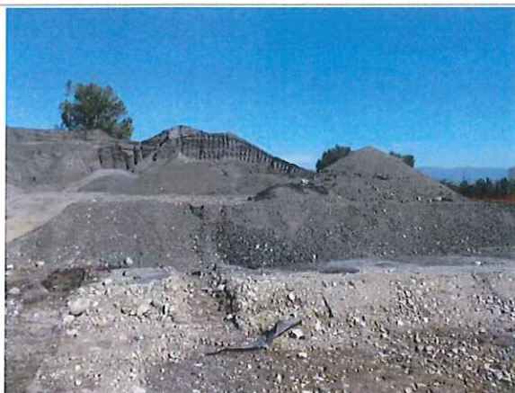
Vista del cumulo A4-2 – fronte accesso cantiere
