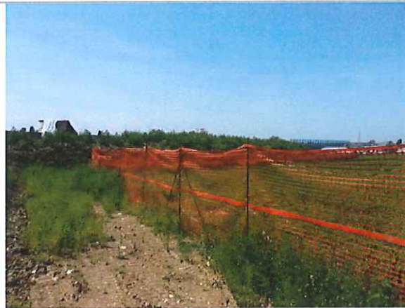
Vista delle reti di delimitazione della duna e del fronte nord della stessa, sullo sfondo a destra le barriere fonoassorbenti attualmente installate sulla A4
