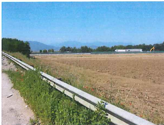
Area Tecnica A7 – vista da imbocco sud del cavalcavia Cavallera – foto del 22/05/17
