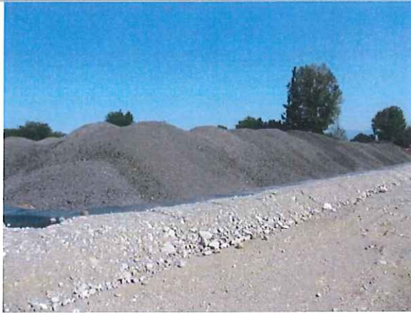
Vista del cumulo A4-2 – fronte accesso cantiere
