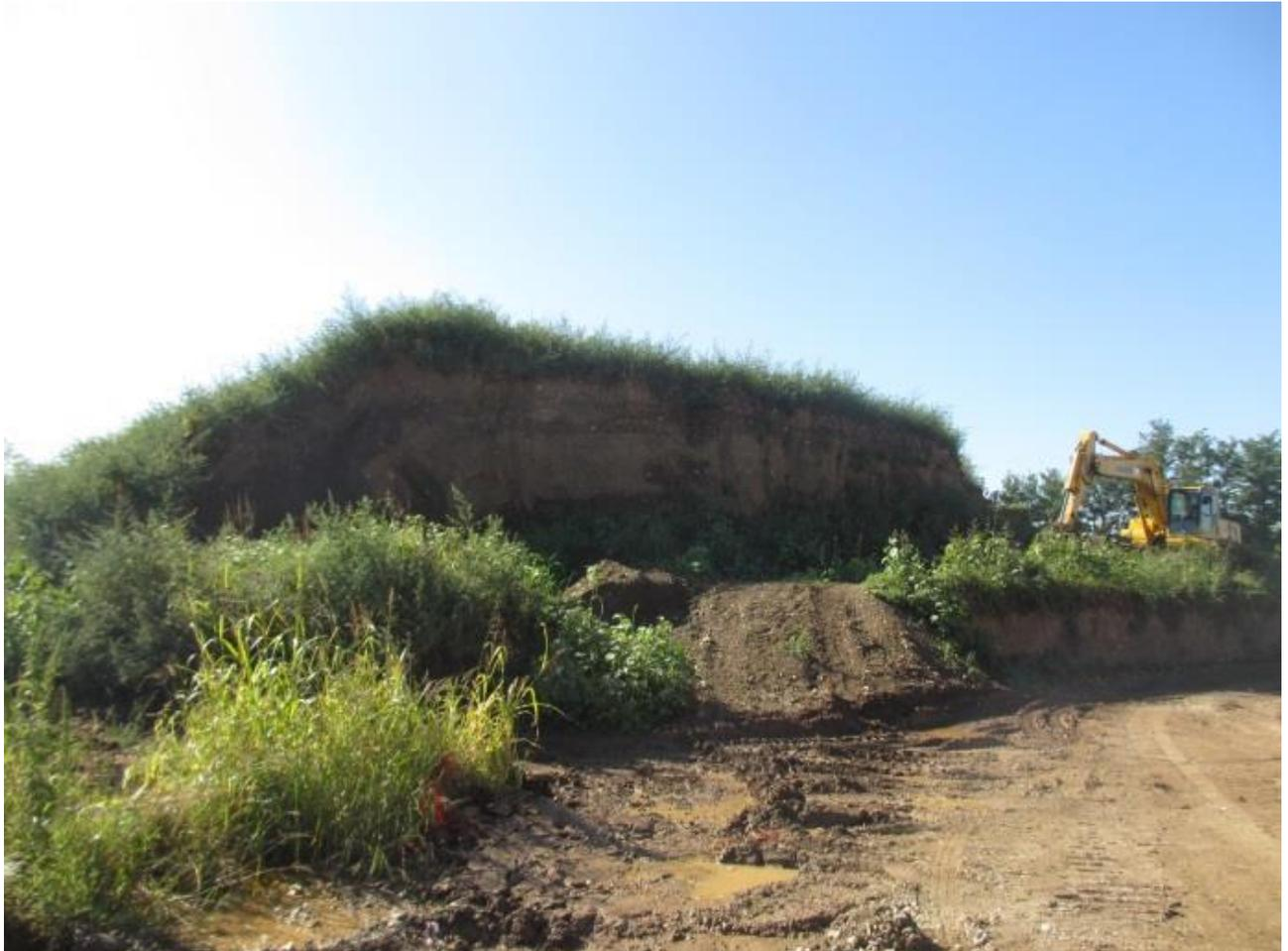
Dall'immagine del cumulo CB-1 si può stimare un'altezza abbondantemente superiore ai 3 m. Si ricorda che elevate altezze dei cumuli possono comportare una eccessiva compattazione del terreno, in particolare in corrispondenza del nucleo del cumulo, con conseguenziali impatti su struttura e fertilità del suolo. Dovrà pertanto essere valutata la necessità di interventi specifici in funzione dell'utilizzo del suddetto terreno nella fase PO.
