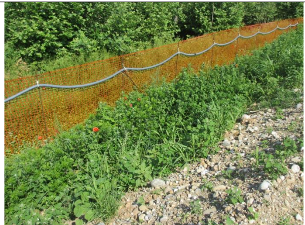
Dettaglio duna A3-4 sul lato ovest del cantiere
