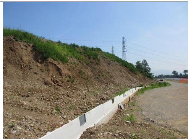
Vista del cumulo A1-1 da pista di cantiere sul lato sud, in primo piano nuovo manufatto idraulico
