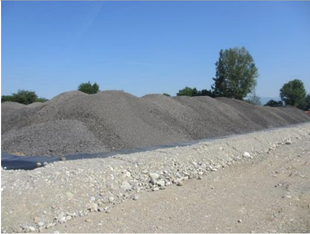
Vista del cumulo A4-2 – fronte accesso cantiere
