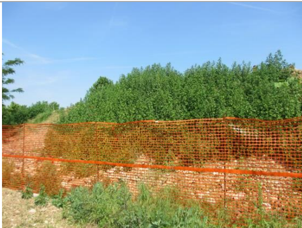
Vista del cumulo A2-1 da sedime autostradale (lato sud)
