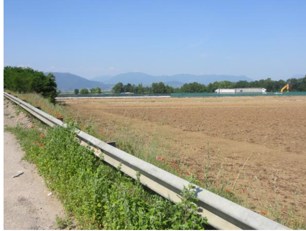
Area Tecnica A7 – vista da imbocco sud del cavalcavia Cavallera – foto del 22/05/17
