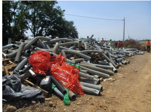
Materiale vario in attesa di smaltimento
