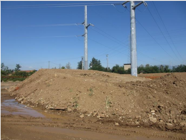
Vista cumulo A3-1 da ingresso cantiere (nella parte bassa si osserva l'eliminazione del cumulo di inerti A3-2)
