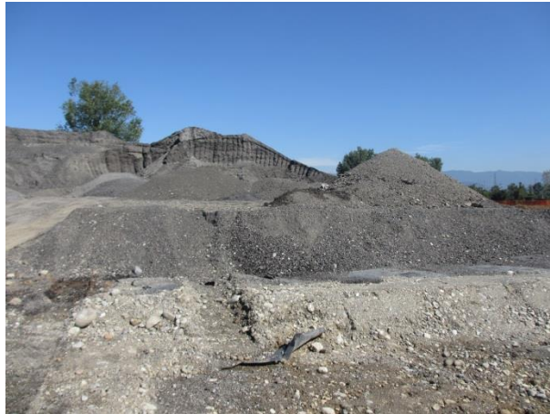
Vista del cumulo A4-2 – fronte accesso cantiere
