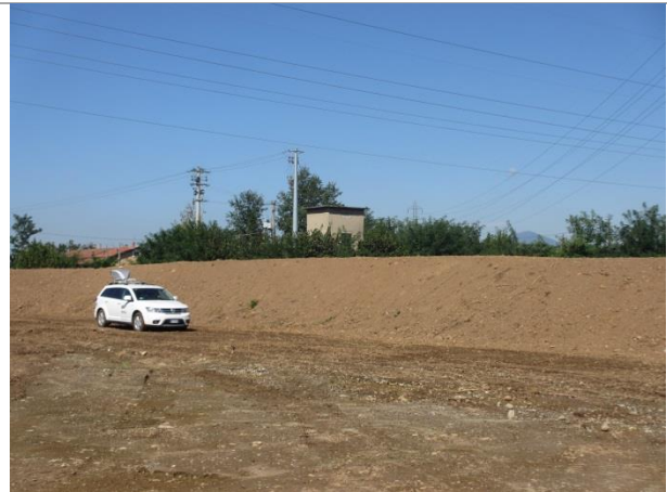
Vista della duna A3-4 sul lato nord-est del cantiere
