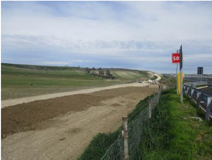
INP 200B Stesa materiale da rilevato da trattare a calce, sez. 10 sez. 26 circa, settimo strato
