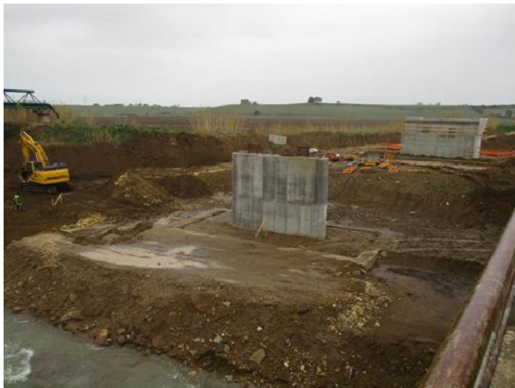
VIP03 Viadotto Mignone – Elevazioni Spalla A e Pila n.1 completate
