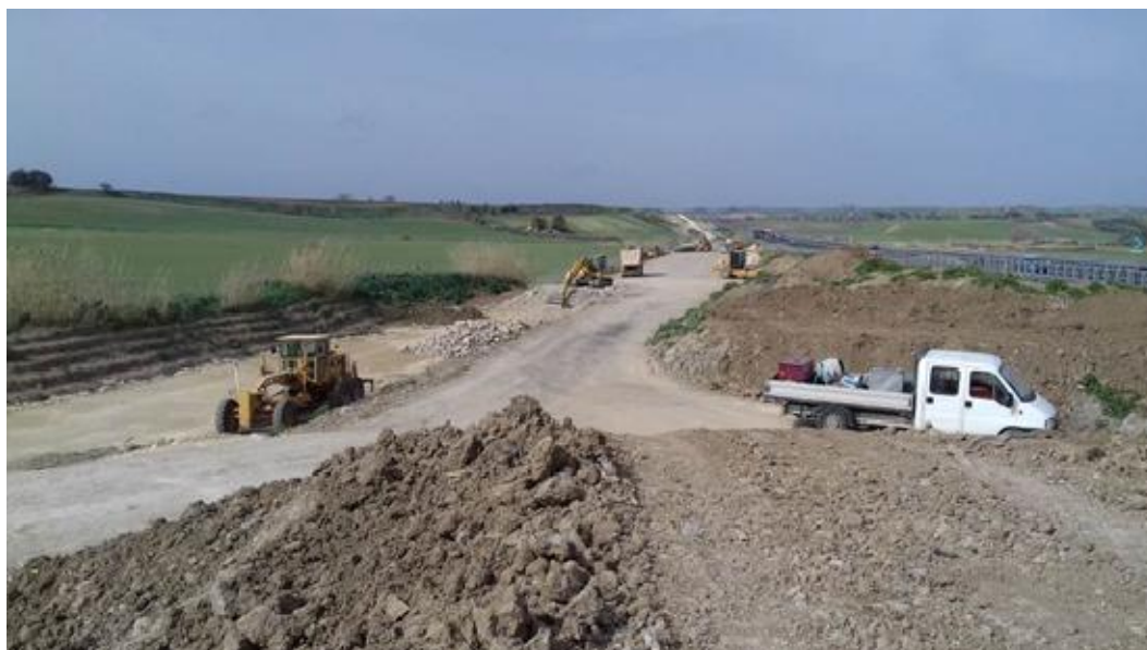
INP 200B Formazione rilevato tra la sez. 10 e la sez. 30
