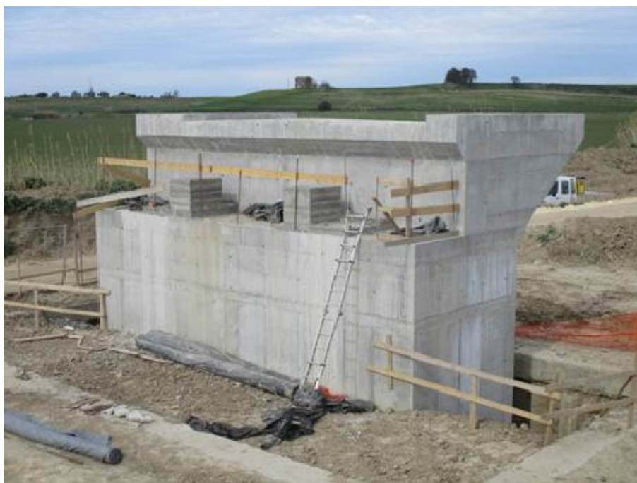
VIP03 Viadotto Mignone – Elevazione Spalla A completa di baggioli
