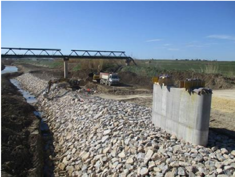
Riprofilatura alveo fiume Mignone – Scogliera in sponda Dx, tra la Pila 2 e fine intervento
