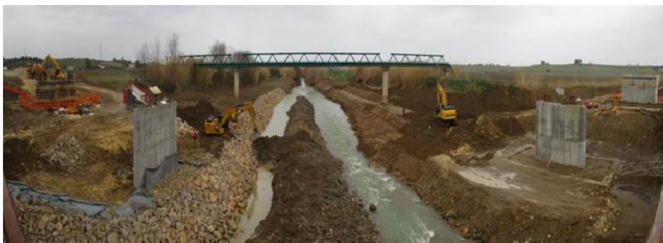
Riprofilatura alveo fiume Mignone lato valle e vista delle opere del viadotto Mignone
