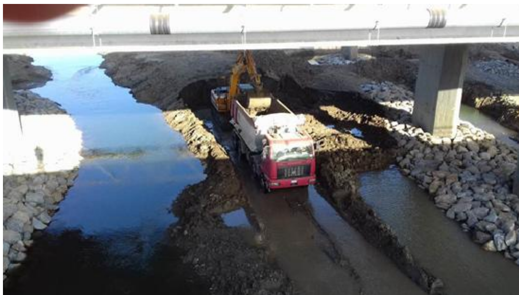
Riprofilatura alveo fiume Mignone – Asportazione dell'argine provvisorio, dalla A12 verso monte
