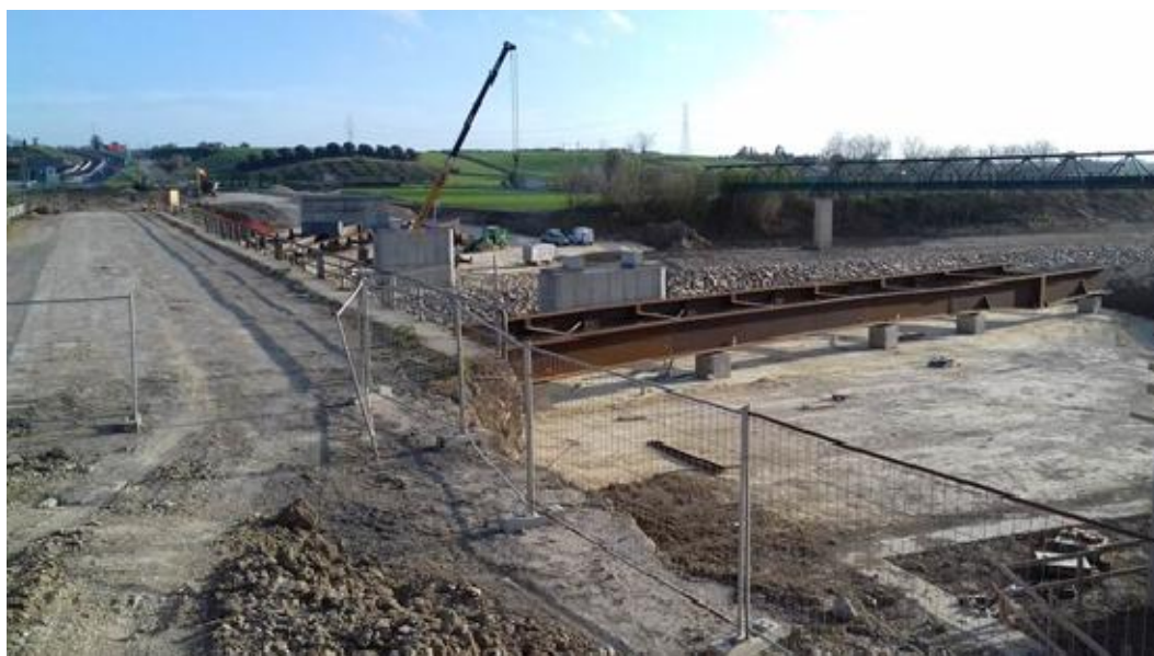
VIP03 Viadotto Mignone – Assemblaggio impalcato in acciaio corten
