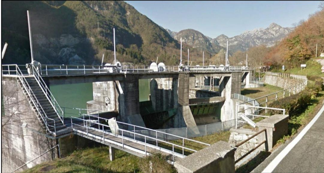
Lo scarico di superficie in corpo diga a ciglio sfiorante è ubicato nel corpo diga ed è costituito da otto luci sfioranti della lunghezza complessiva di 50 m, con soglia a quota 313,40 m s.l.m., praticate sul coronamento della diga (si veda la Figura 3.1e).
