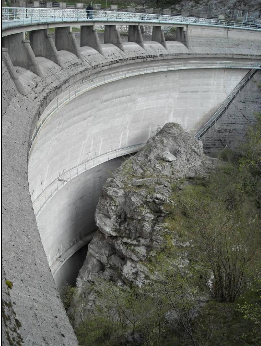
La Diga dispone di uno scarico di superficie in corpo diga a ciglio sfiorante, di uno scarico di superficie in sponda sinistra presidiato da paratoie a ventola e a settore, di uno scarico di fondo e di uno scarico di esaurimento.
