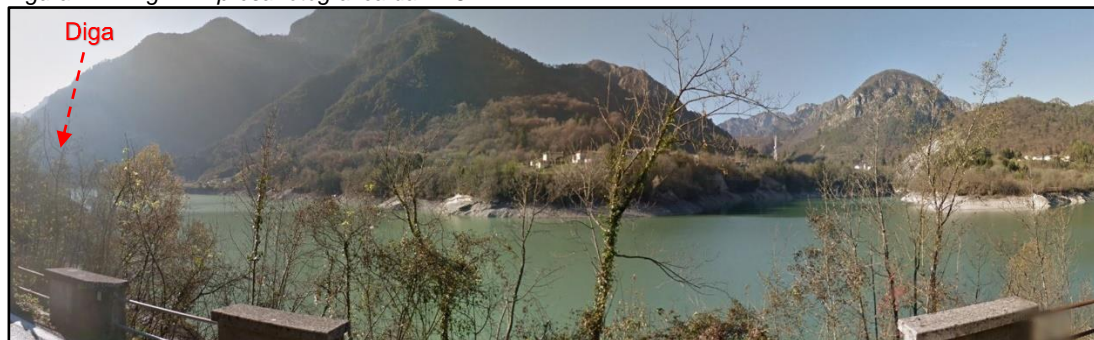
Figura 4.1.2.2g Ripresa fotografica da PV5
