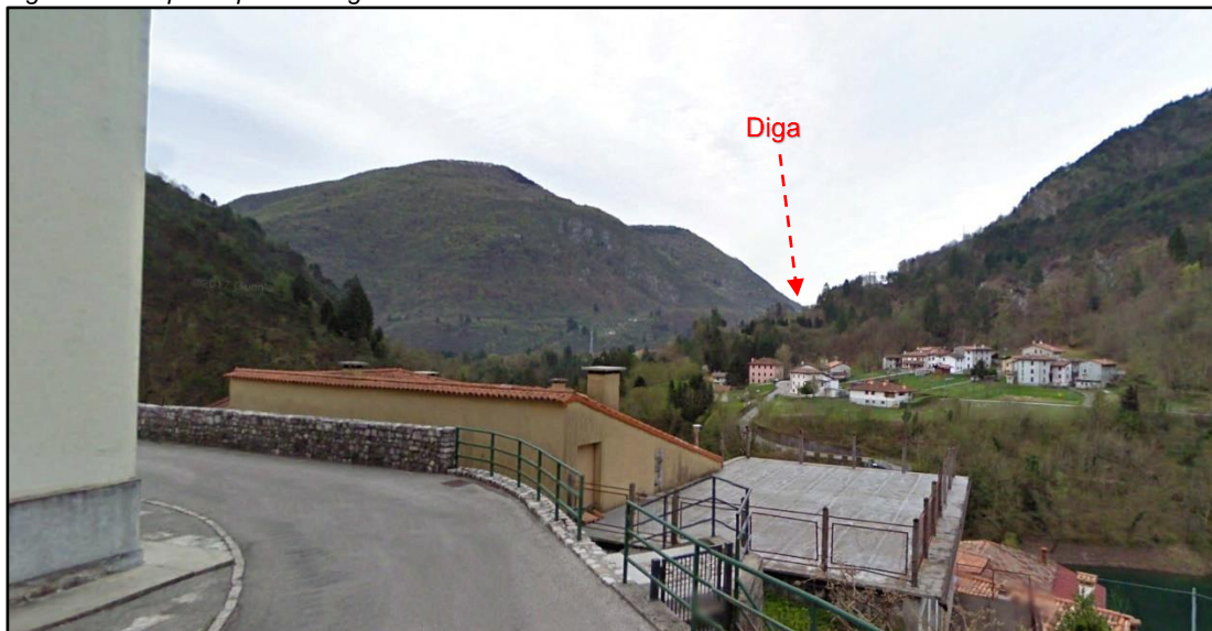
Figura 4.1.2.2q Ripresa fotografica da PV10 – Frazione di Chievolis
