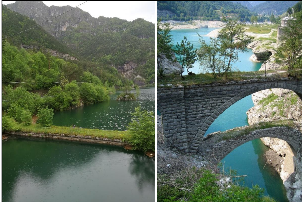
Figura 4.1.3a Vecchio Ponte Racli (parzialmente sommerso e totalmente scoperto)
