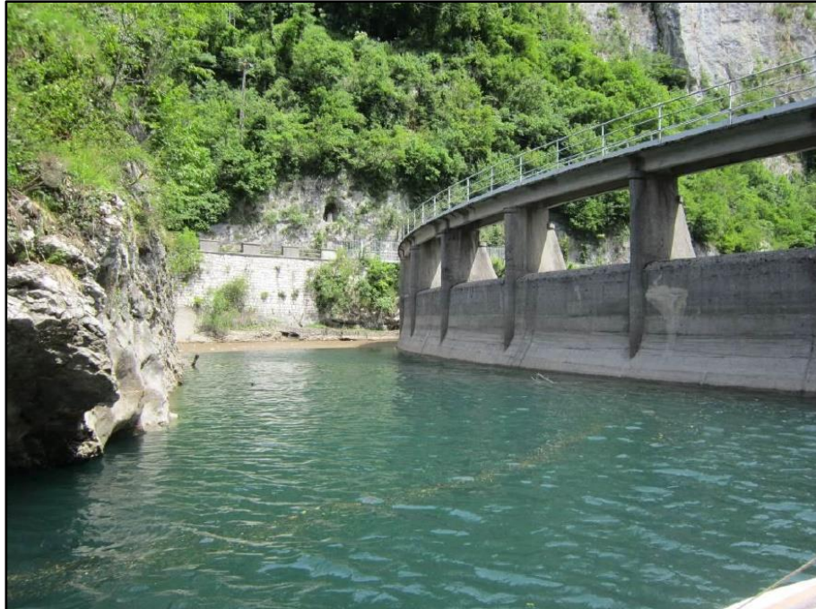
Figura 2.3.2f Vista della diga di Ponte Racli da monte
