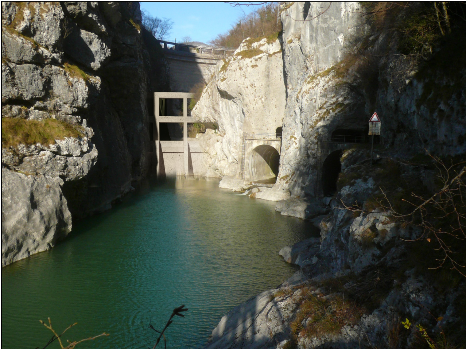
Figura 4.1.2.2.1s (2di2) Fotoinserimenti a valle dello sbarramento nei pressi dello sbocco della galleria degli scarichi di superficie - Stato futuro
