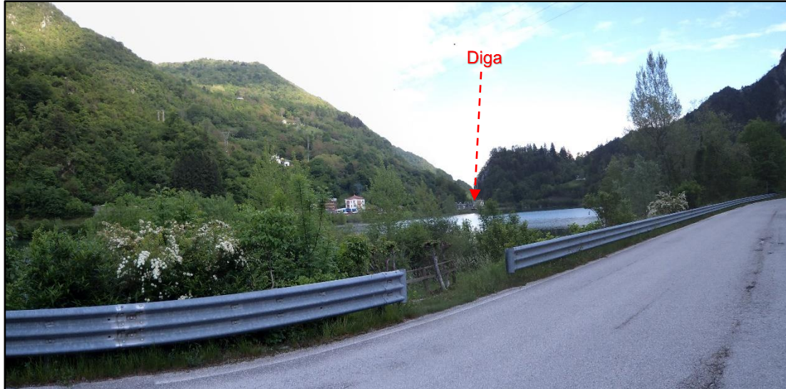
Figura 4.1.2.2i Ripresa fotografica da PV7
