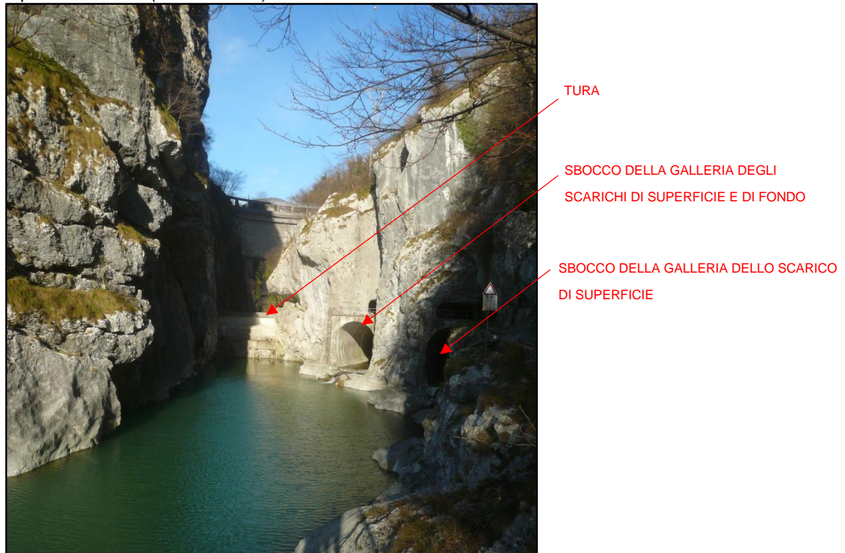
Figura 6.1d Vista degli sbocchi delle gallerie dello scarico di superficie (sbocco a est) e degli scarichi di superficie e di fondo (sbocco a ovest)
