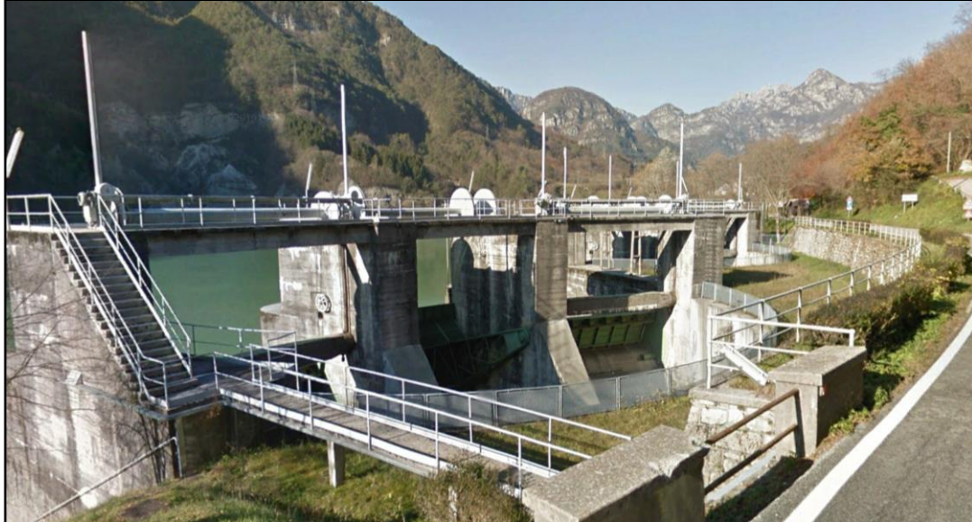
Figura 6.1b Vista dello scarico di superficie in sponda sinistra
