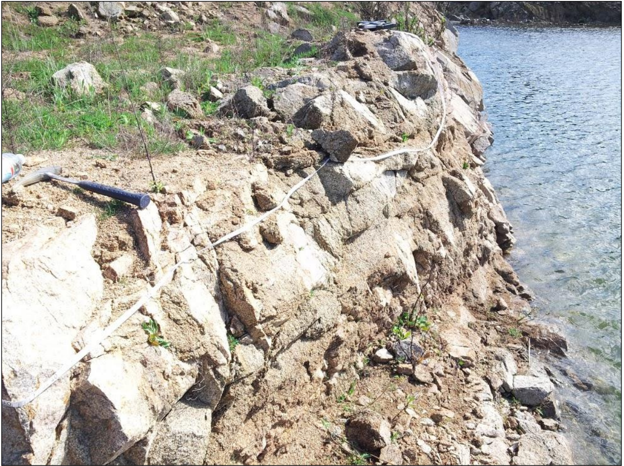
Figura 22 – Stazione di rilevamento geomeccanico dell’ammasso roccioso “St_04”. In evidenza la linea di scansione.
