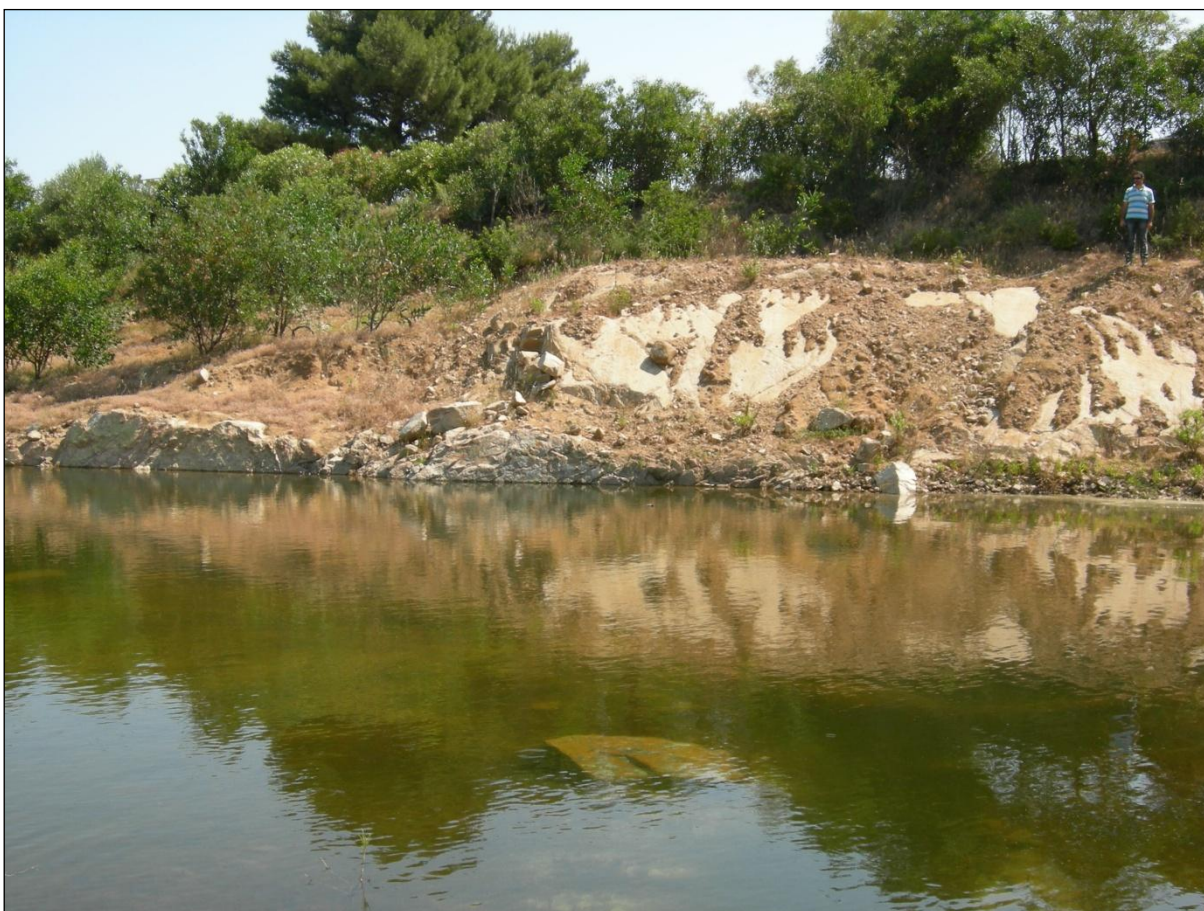
Figura 7 – Foto mostrante l'Unità Litotecnica A caratterizzata da granodioriti massivi e poco alterate della Facies Porto Rotondo affioranti nel fronte di scavo orientale.
