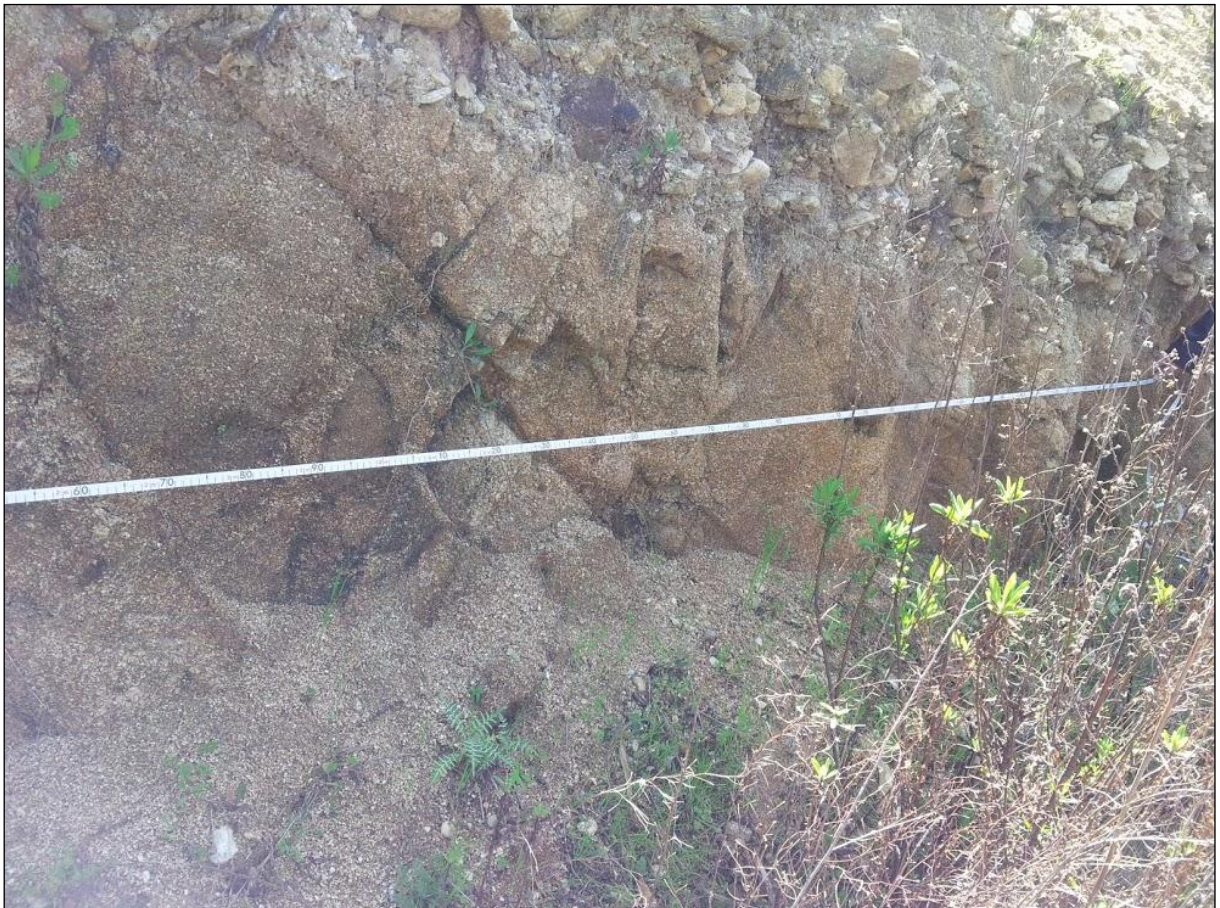
Figura 24 – Stazione di rilevamento geomeccanico dell'ammasso roccioso "St_05". In evidenza la linea di scansione.
