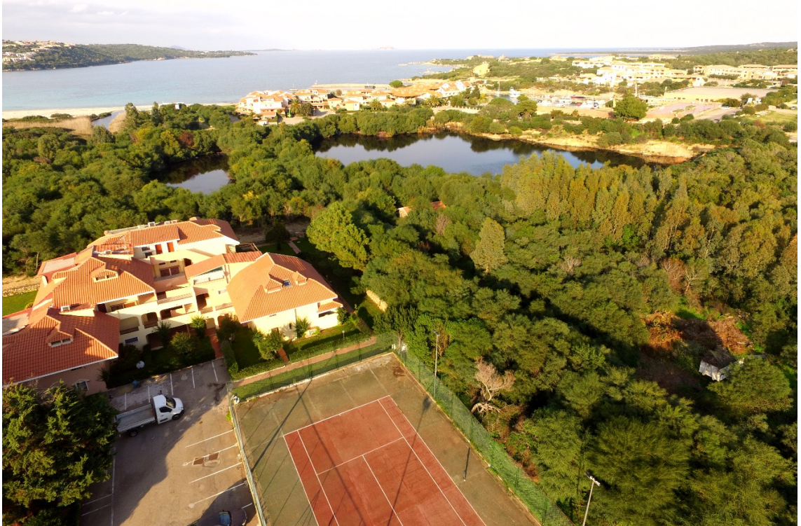
Foto 1 – Stato di fatto
