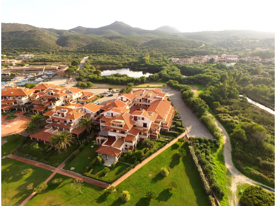
Foto 2 – Stato di fatto
