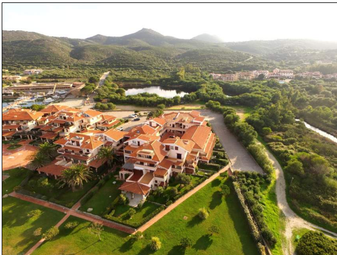
Foto: Stato di fatto
