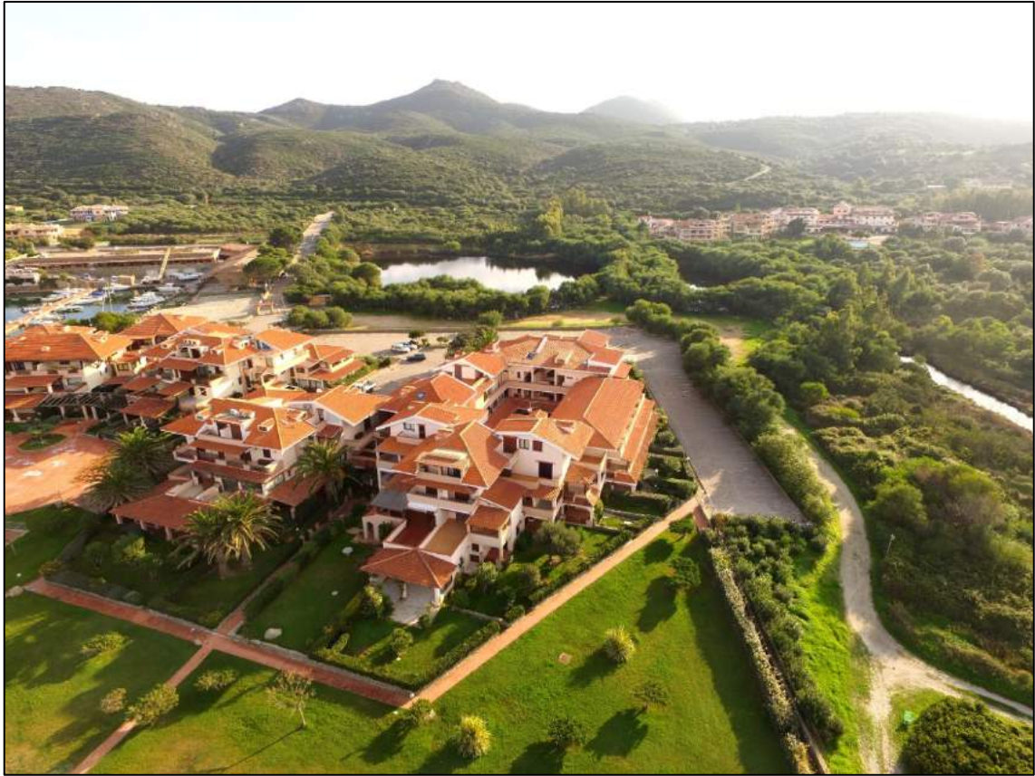
Foto 3: Stato di fatto
