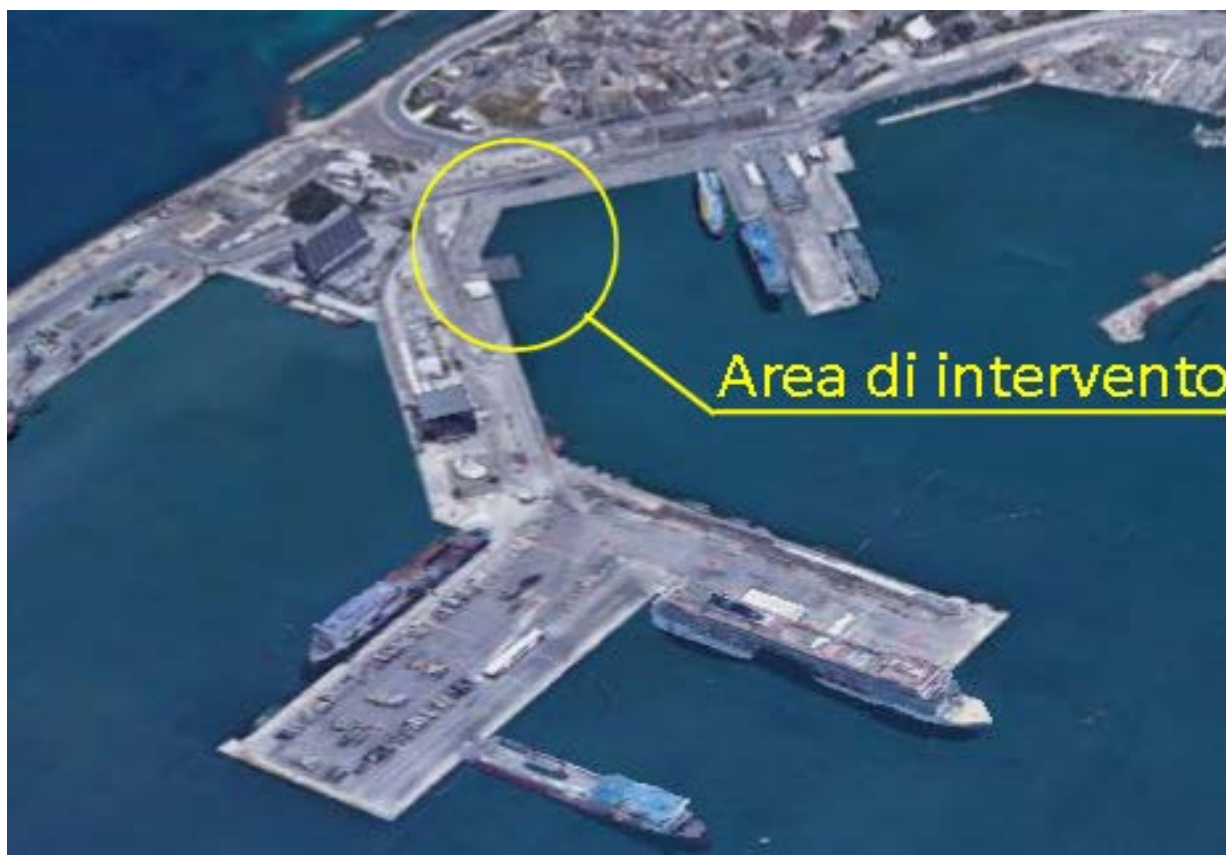
Fig. 5 – Area di intervento – si nota il raccordo a forma spezzata ed il pontone utilizzato per l’ormeggio dei traghetti
