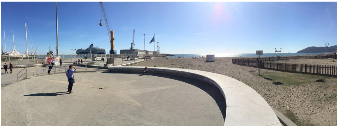
PANORAMICA DELLE AREE A TERRA OGGETTO DI INTERVENTO
