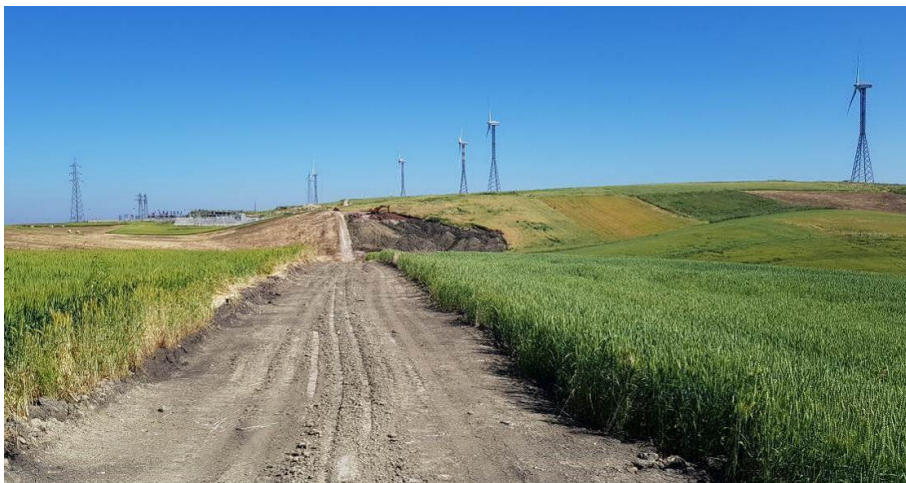
Figura 8: parte della fila degli aerogeneratori distinti con gli identificativi da BS09 a BS35
