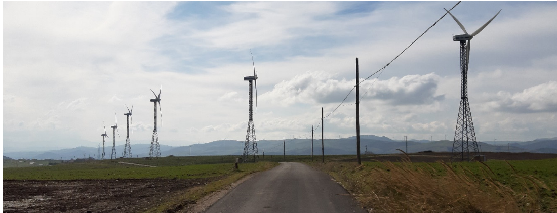
Figura 15: aerogeneratori esistenti con torre tralicciata
