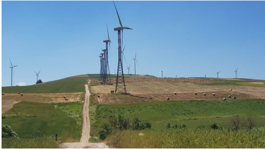
Figura 13: strada di collegamento tra R-BS02 e R-BS03.
