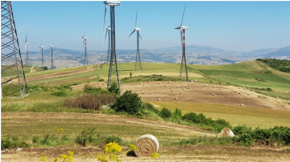
*Figura 76: file di aerogeneratori V47 posti lungo linee di crinale con pendenze poco accentuate*
