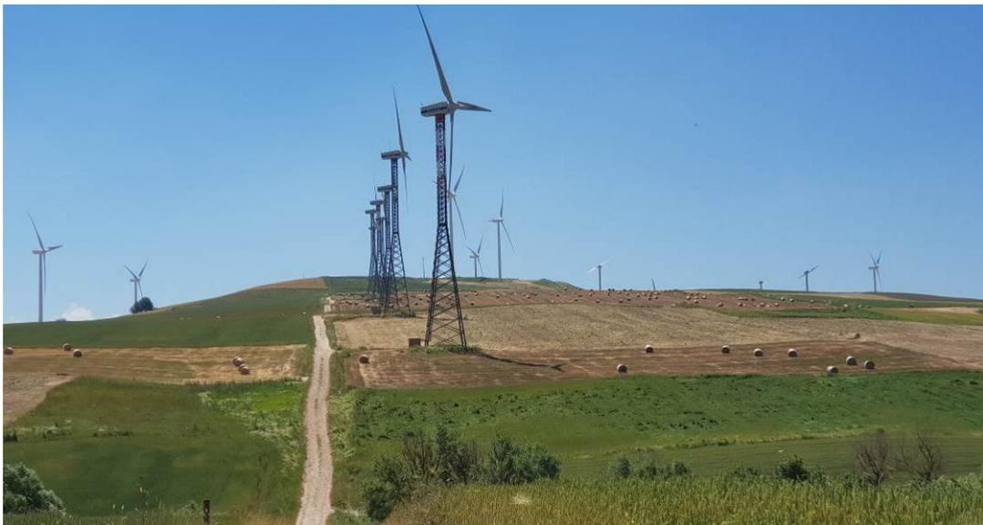
*Figura 77: fila degli aerogeneratori esistenti da BS01 a BS08. Lo stesso crinale sarà occupato esclusivamente da 3 aerogeneratori moderni.*
