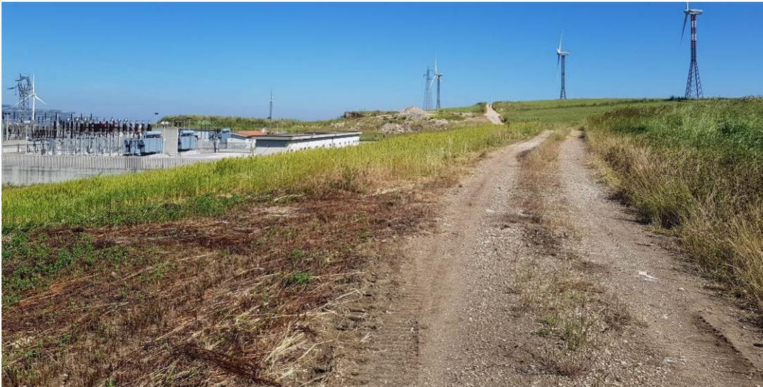
*Figura 84: tratti della strada che serve l'impianto esistente e da cui si accederà per la realizzazione degli aerogeneratori con sigle da R-BS01 a R-BS10. In alto si notano i danni fatti dal ruscellamento dell'acqua sulla sede stradale causato dalla cattiva tenuta delle cunette stradali. La strada avrà bisogno di sistemazione delle cunette, di interventi di allargamento della sede carrabile, di rifacimento della massicciata e di ricarica puntuale con stabilizzato di cava.*
