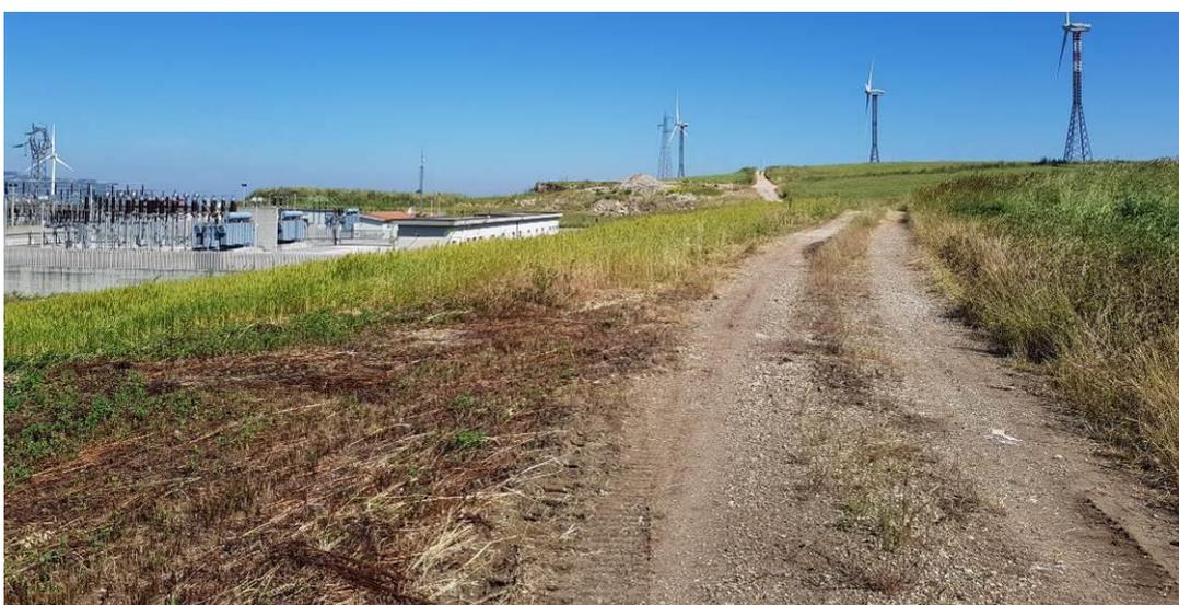
**Figura 10: tratti della strada che serve l'impianto esistente e da cui si accederà per la realizzazione degli aerogeneratori con sigle da R-BS01 a R-BS10. In alto si notano i danni fatti dal ruscellamento dell'acqua sulla sede stradale causato dalla cattiva tenuta delle cunette stradali. La strada avrà bisogno di sistemazione delle cunette, di interventi di allargamento della sede carrabile, di rifacimento della massiciata e di ricarica puntuale con stabilizzato di cava.**
