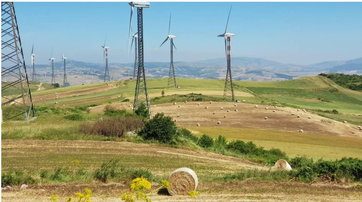
Figura 1: file di aerogeneratori V47 posti lungo linee di crinale con pendenze poco accentuate
