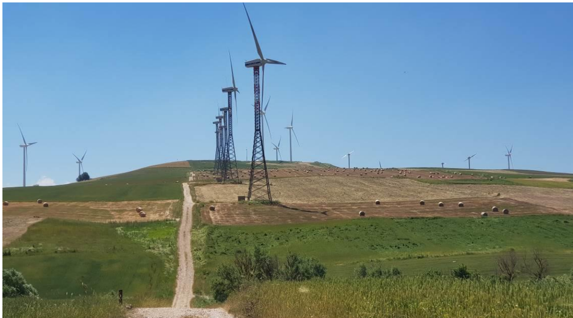
Figura 17: strada di collegamento tra R-BS02 e R-BS03.
