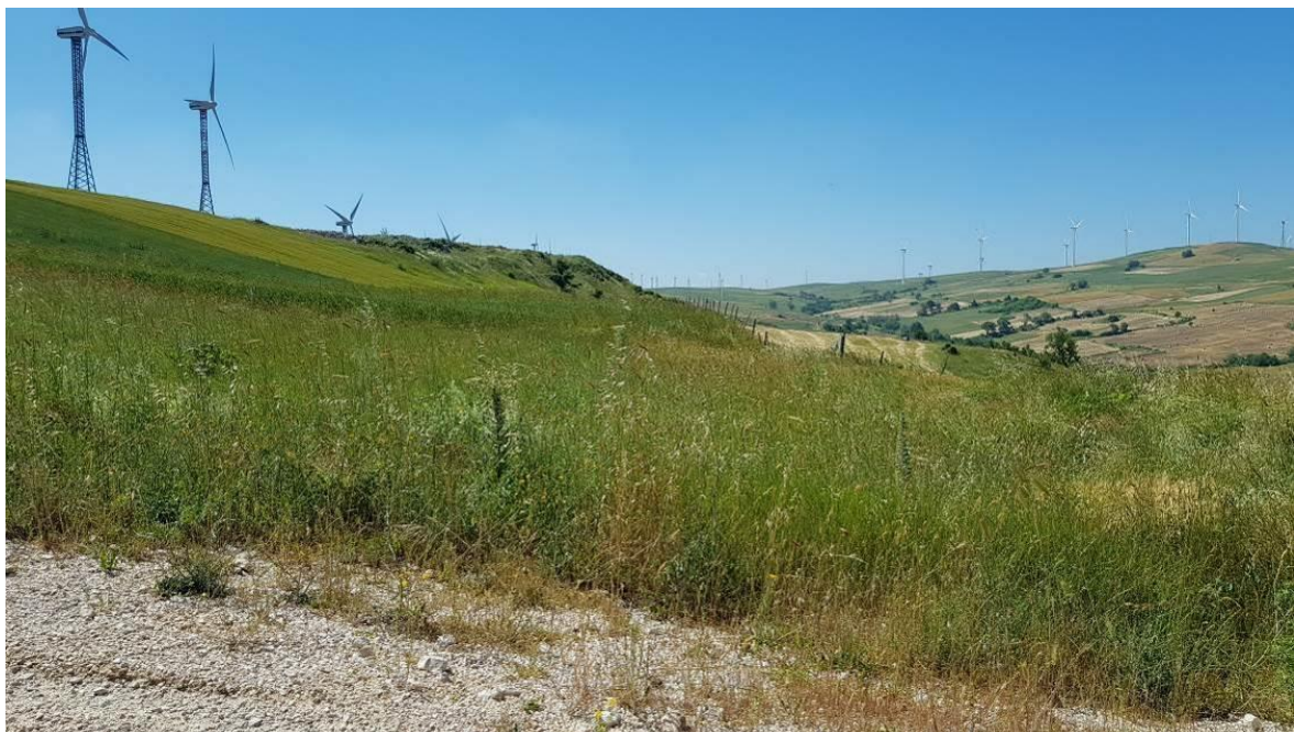
Figura 13: tratto di strada catastalmente esistente che servirà al collegamento tra la postazione dell'aerogeneratore R-BS07 e R-BS08. La strada andrà realizzata ex novo.
