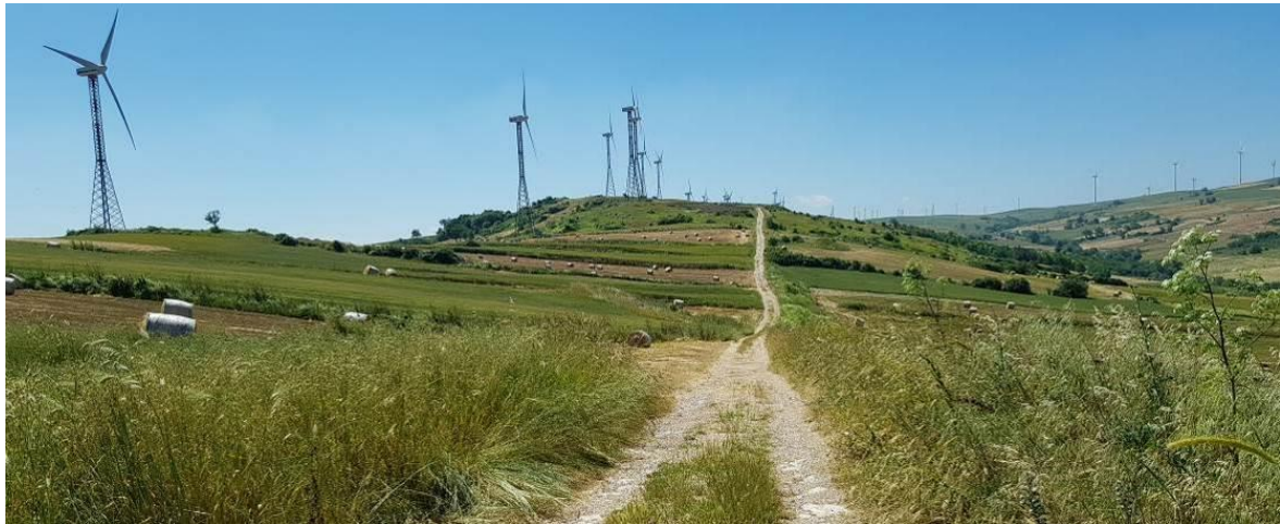
Figura 18: parte della fila degli aerogeneratori distinti con gli identificativi da BS09 a BS35.
