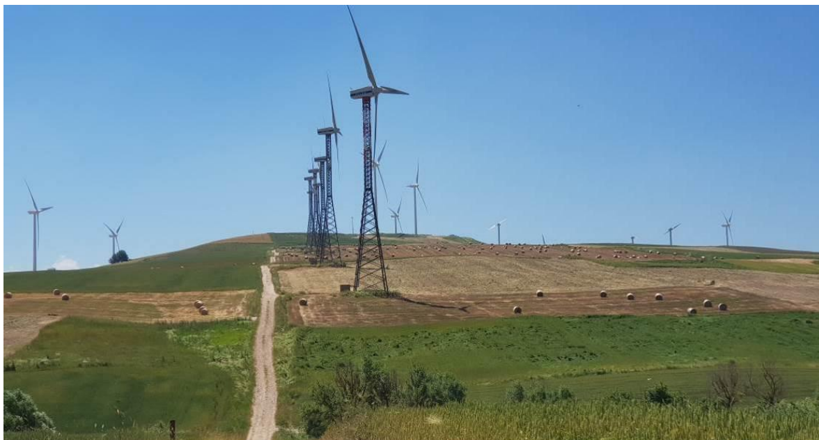
Figura 1: file di aerogeneratori esistenti posti lungo linee di crinale con pendenze poco accentuate
