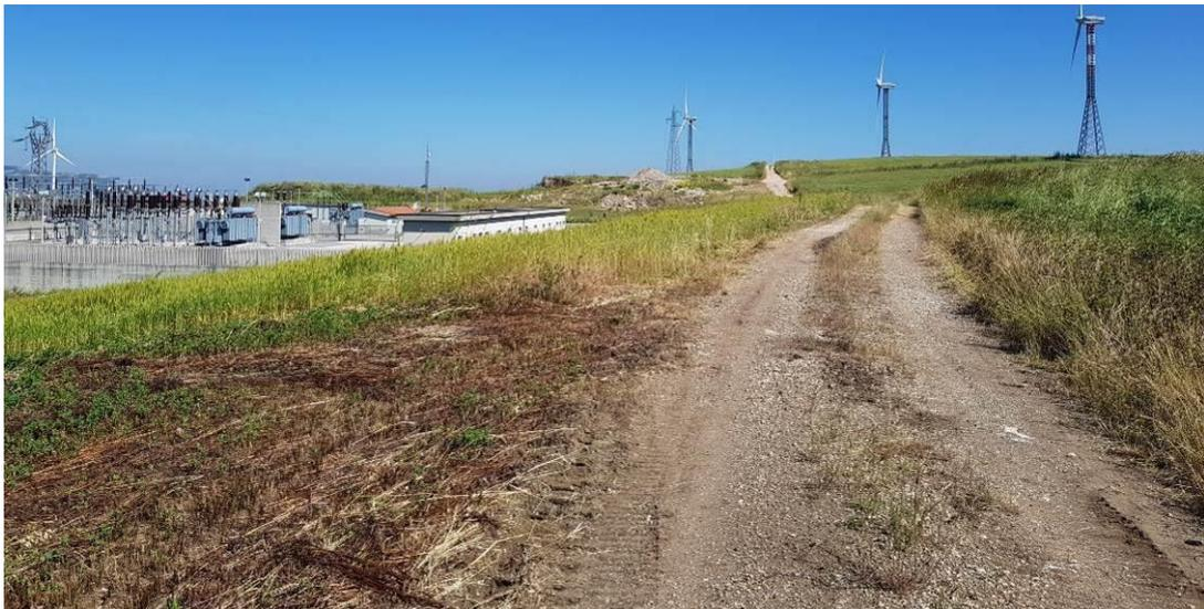
**Figura 2:** tratto della strada che serve l'impianto esistente e da cui si accederà per la realizzazione degli aerogeneratori con sigle da R-BS01 a R-BS10. In alto si notano i danni fatti dal ruscellamento dell'acqua sulla sede stradale causato dalla cattiva tenuta delle cunette stradali. La strada avrà bisogno di sistemazione delle cunette, di interventi di allargamento della sede carrabile, di rifacimento della massicciata e di ricarica puntuale con stabilizzato di cava.
