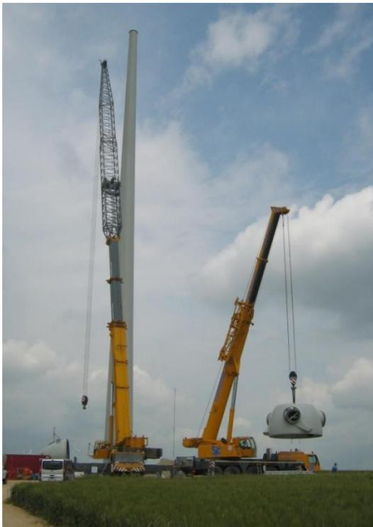
**Figura 5:** smontaggio navicella
