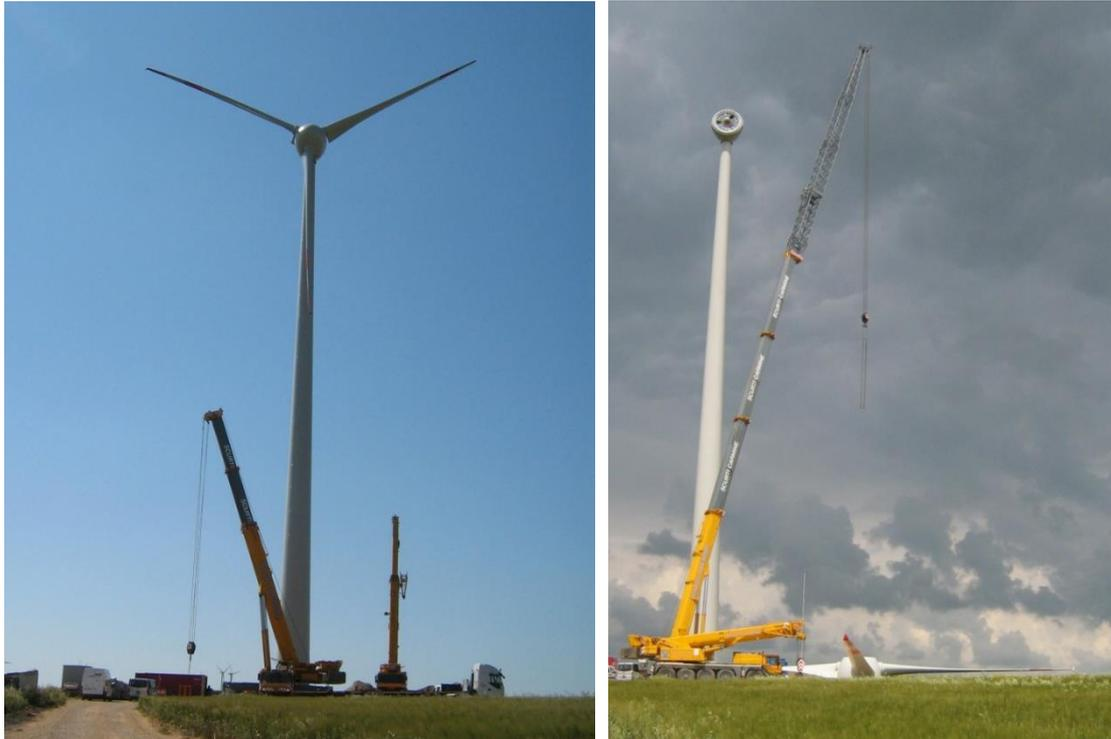
**Figura 4:** rimozione eliche e mozzo
