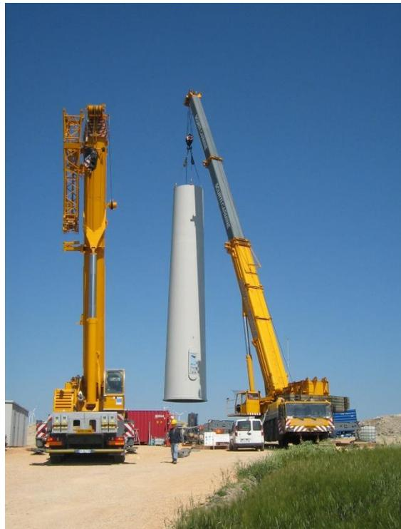
**Figura 6:** particolare smontaggio torre
