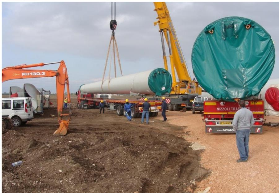
Figura 7: elementi torre smontata pronti per il trasporto
