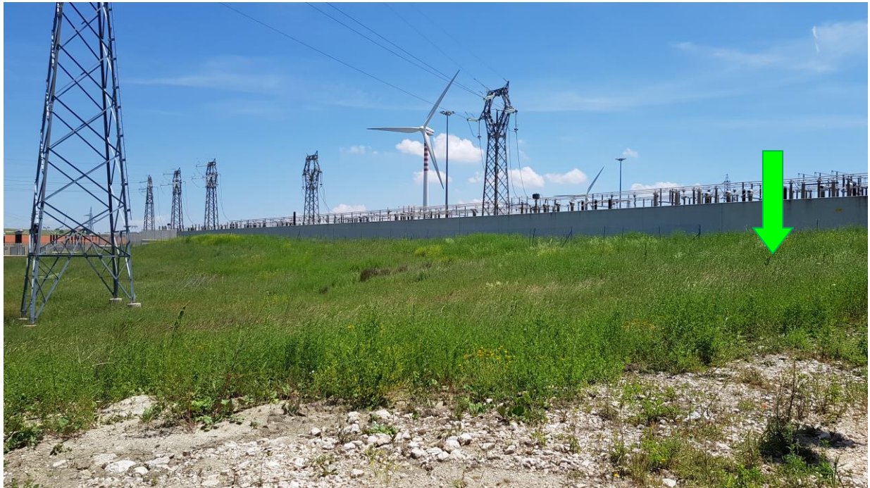
FOTO 15. POSIZIONE NUOVA SOTTOSTAZIONE ELETTRICA DI UTENTE
