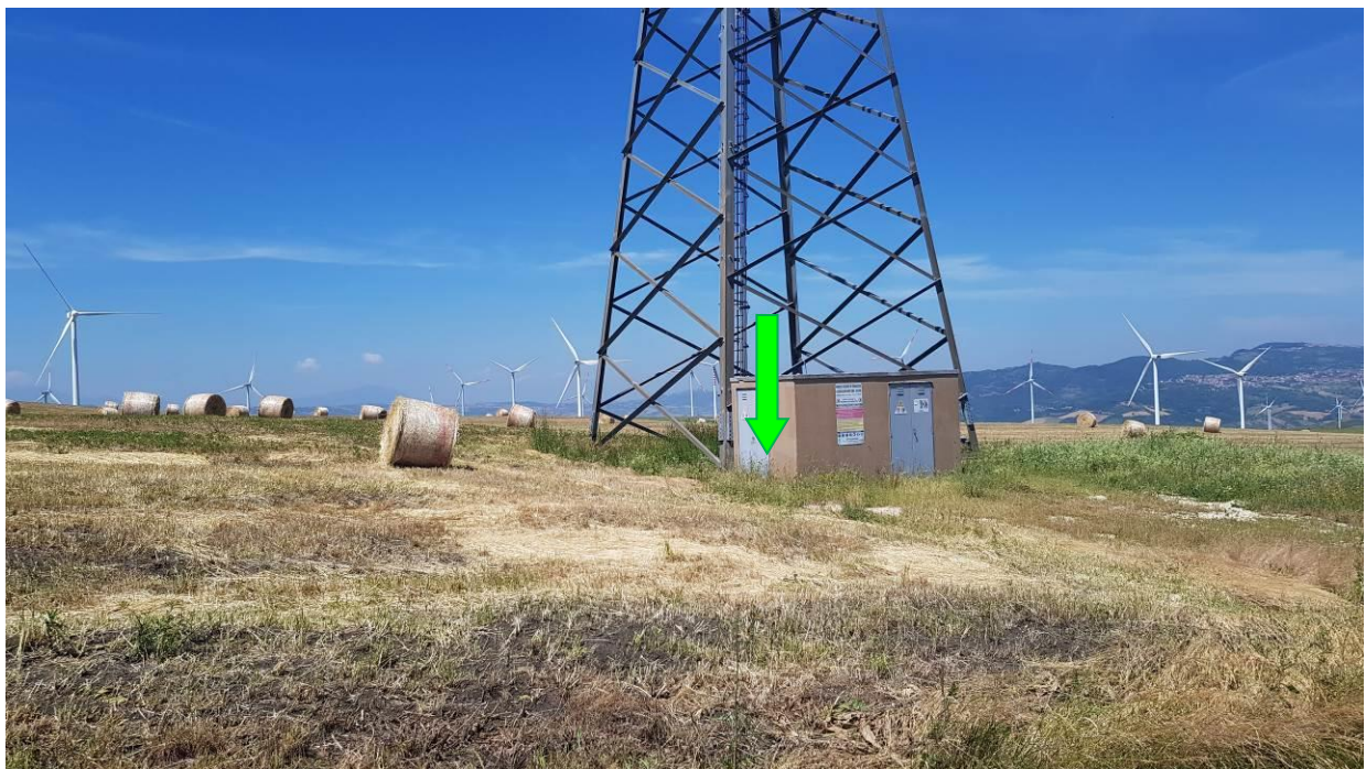
FOTO 4. POSIZIONE AEROGENERATORE R-BS03 AL POSTO DELLA TORRE ESISTENTE BS07
