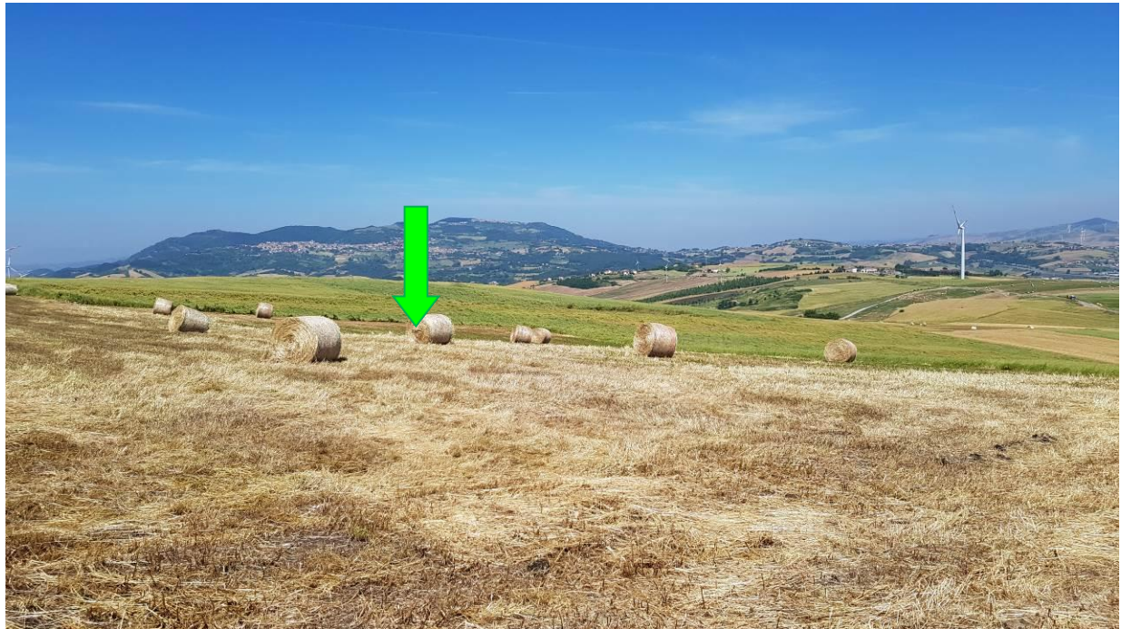
FOTO 5. POSIZIONE AEROGENERATORE R-BS04 VISTA DALLA STRADA ESISTENTE A SERVIZIO DELLE TORRI ESISTENTI BS09-BS32
