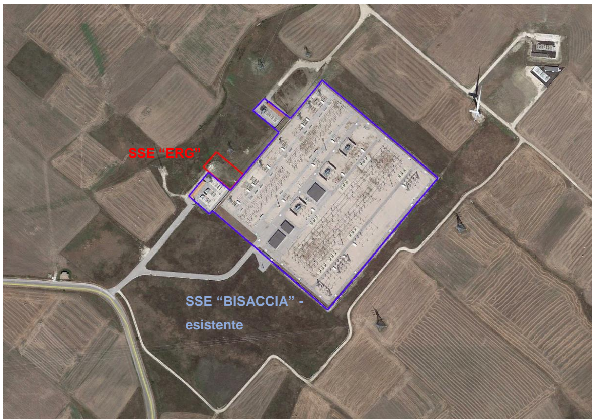
Figura 1 – Inquadramento su ortofoto della sottostazione di Bisaccia e delle aree limitrofe. In blu la sottostazione “Bisaccia” esistente, in rosso la sottostazione ERG da realizzare.
