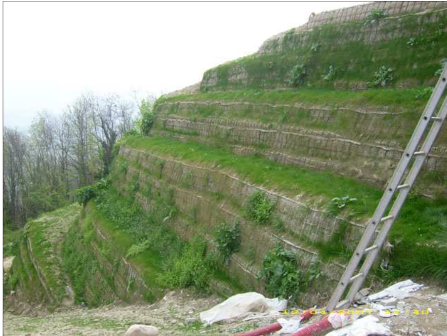
Figura 13: Esempio di rilevato in terre rinforzate.
