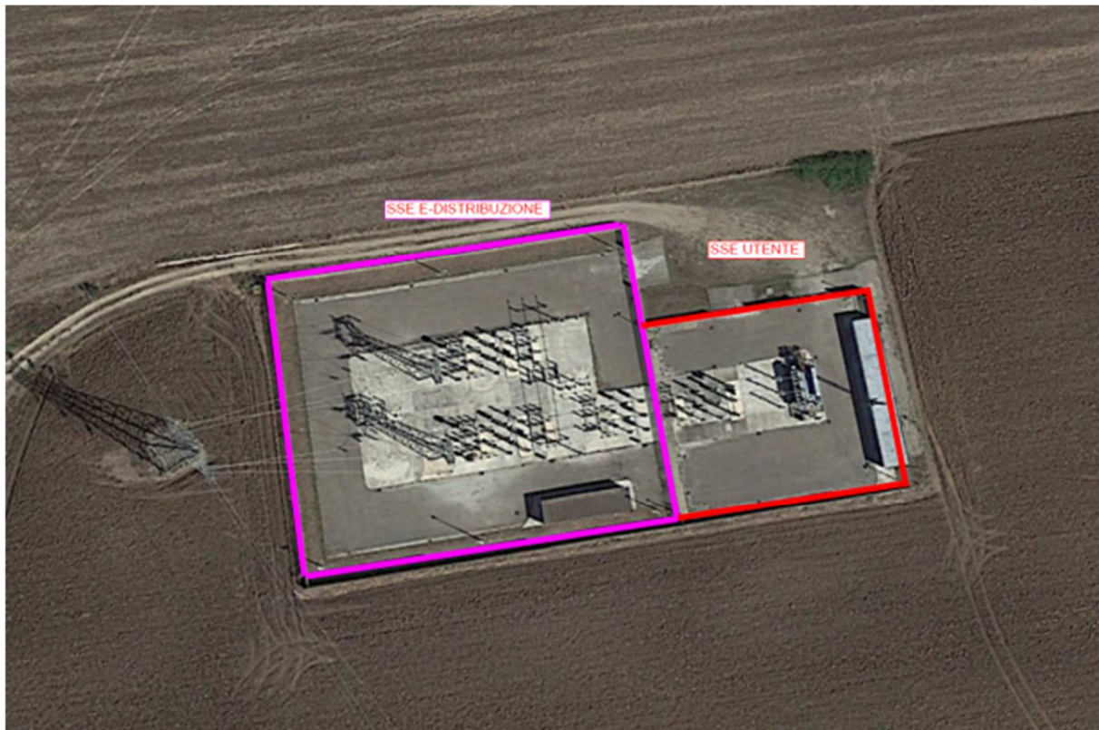
Figura 21: Vista aerea della Stazione elettrica E.Distribuzione e della sottostazione elettrica ERG.
