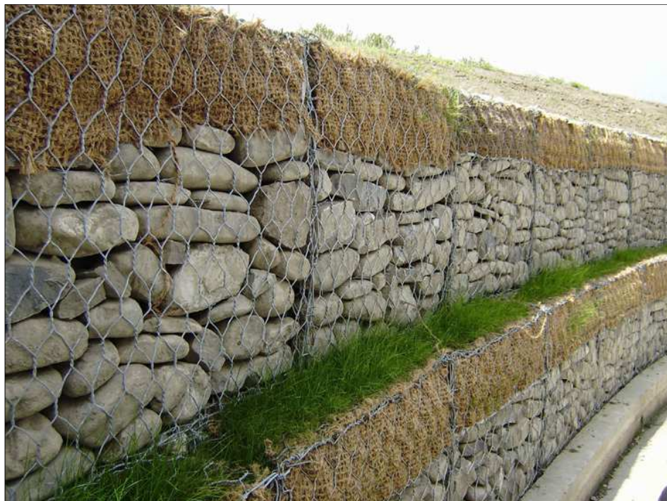
Figura 14: Esempio di opera di contenimento in gabbioni.
