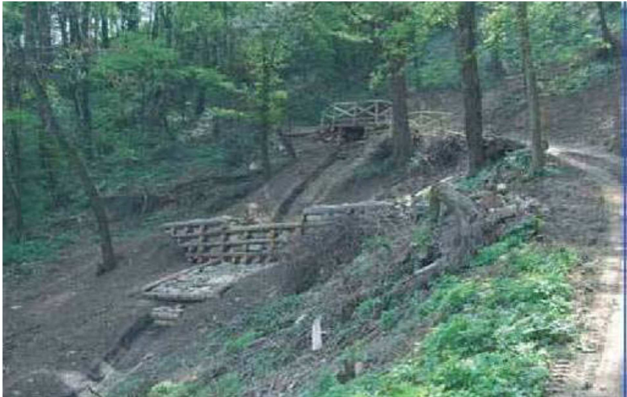
Figura 17: Esempio di briglie in legname e pietrame.
