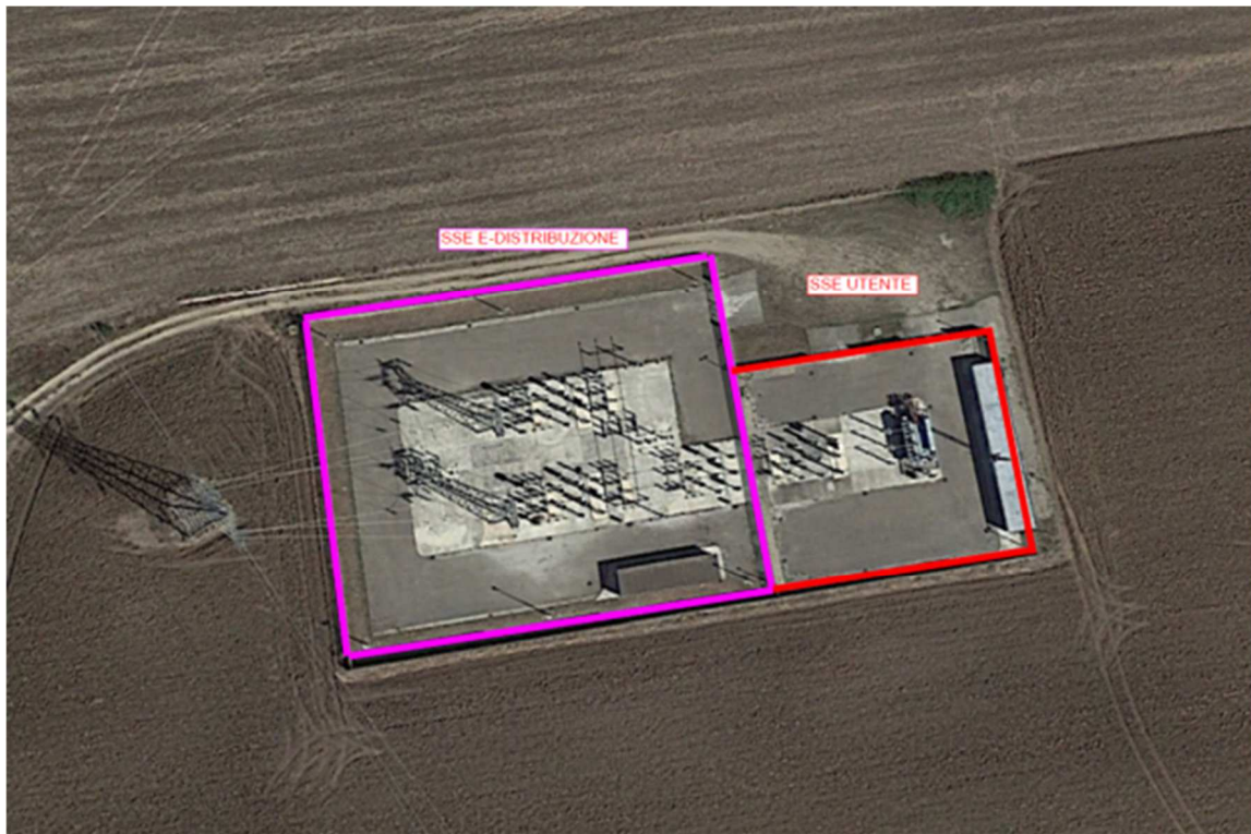
Figura 12: Vista aerea della Stazione elettrica E.Distribuzione e della sottostazione elettrica ERG.
