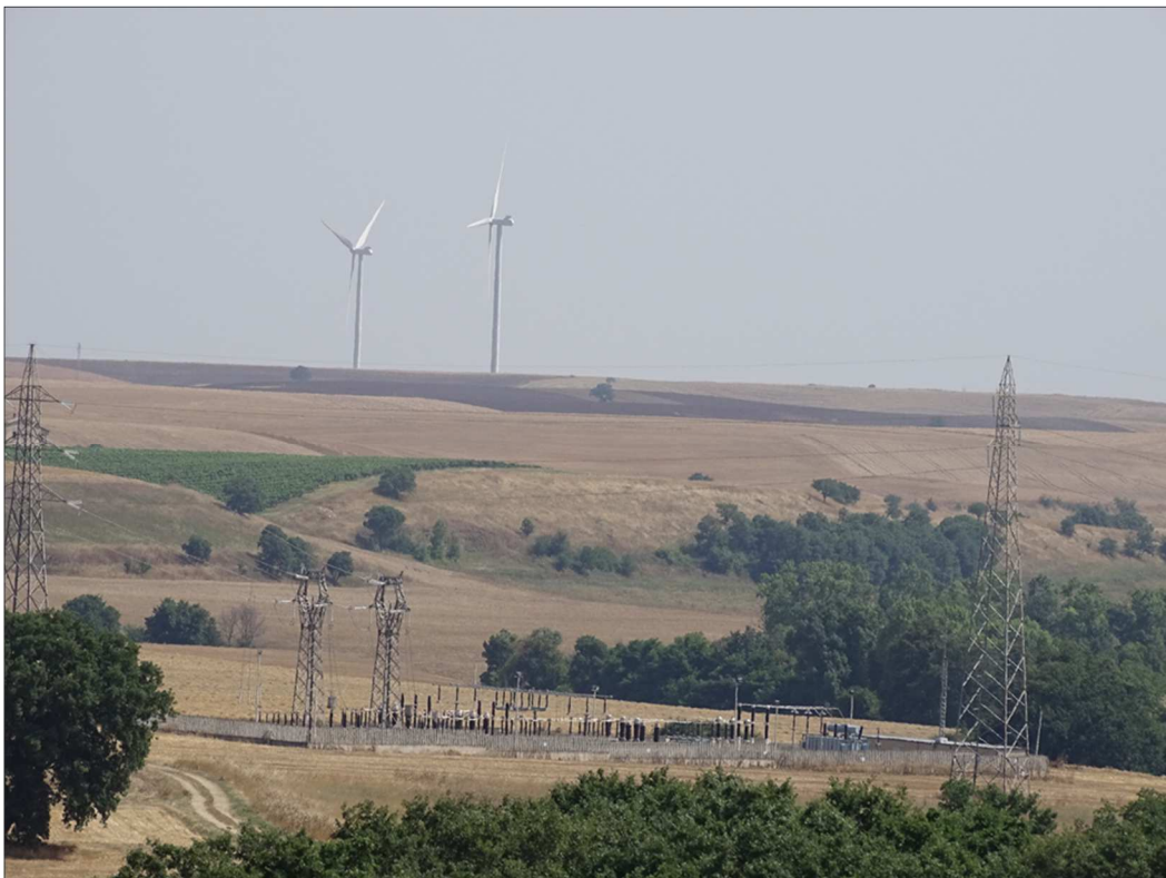
Figura 2: Vista della Stazione Elettrica di consegna
