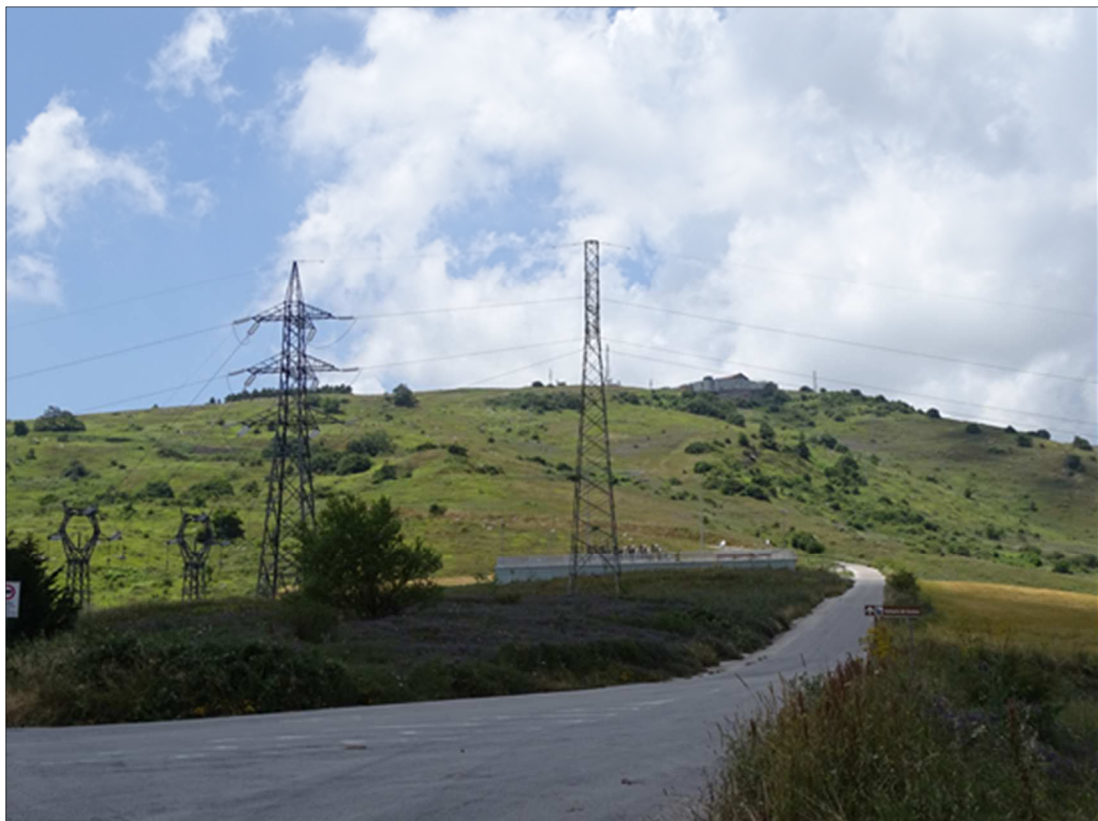
Figura 13: Vista della Sottostazione esistente E.Distribuzione .
