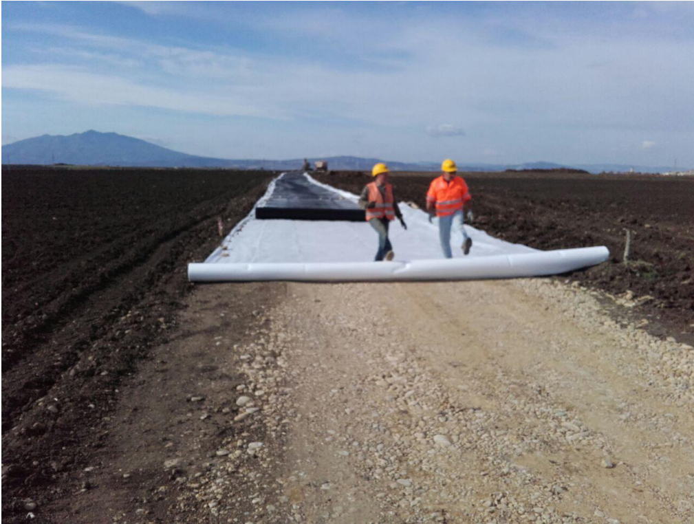
Figura 2_Copertura provvisoria piste temporanee e di cantiere
