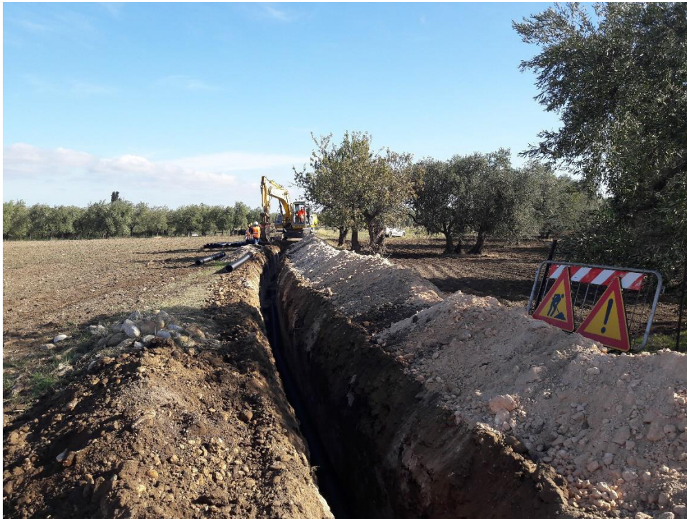
Figura 3_Realizzazione cavidotto
