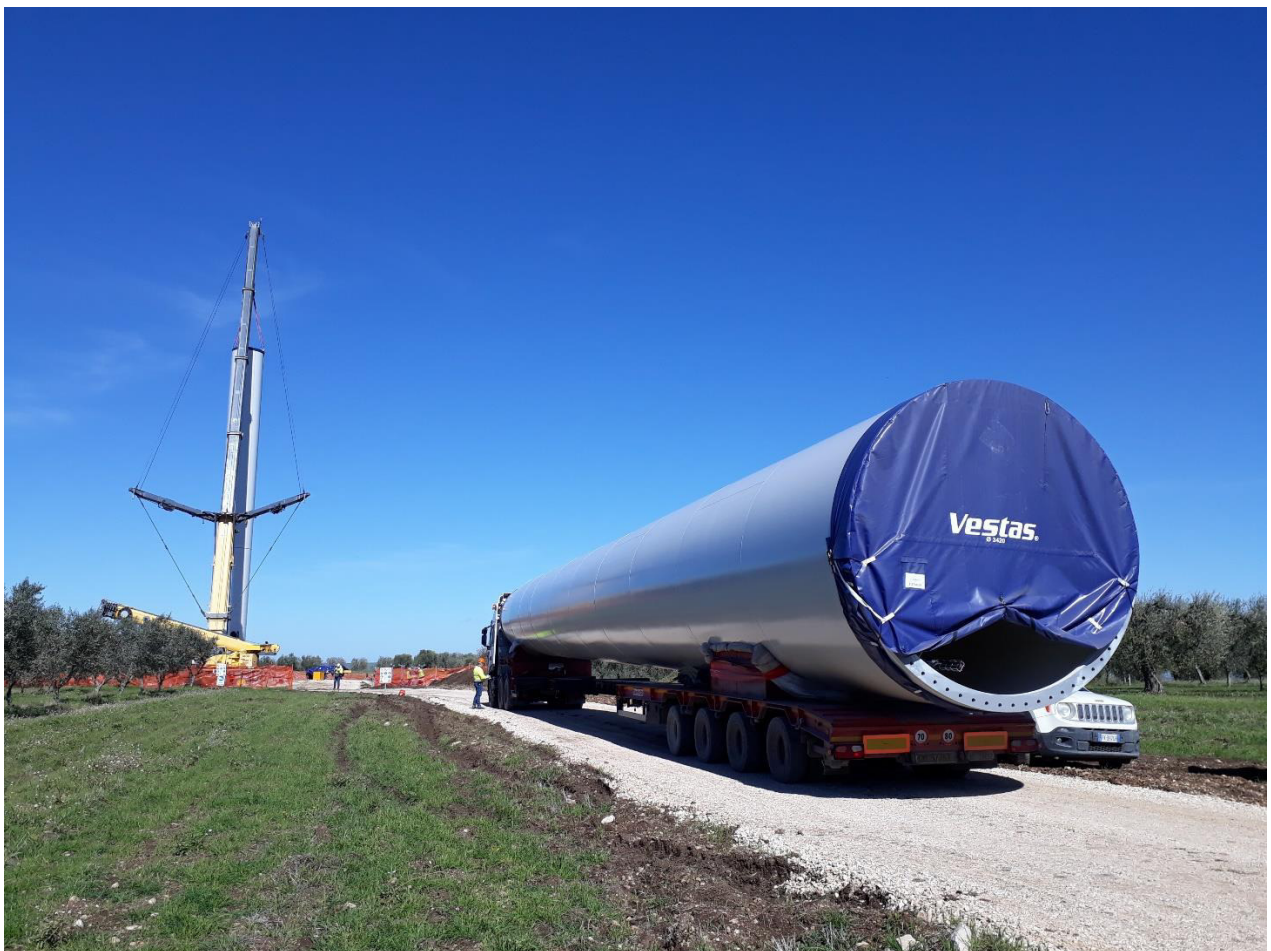
Figura 7_Esempio trasporto conci di torre - Parco Eolico di Proprietà -Basilicata
