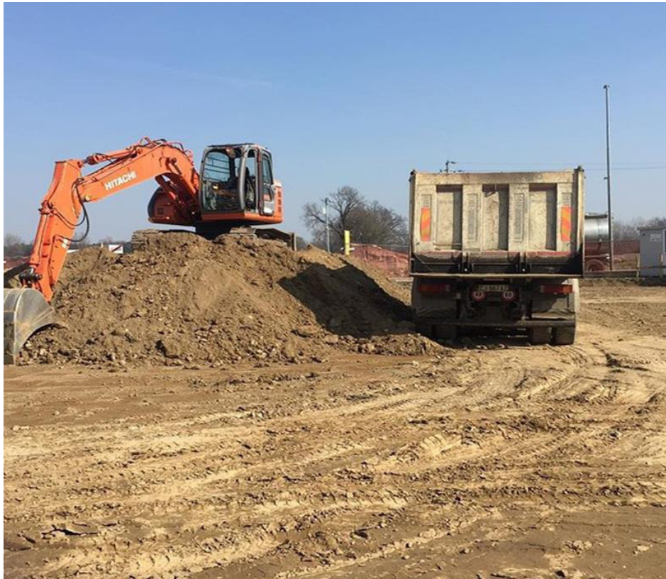
Figura 1_Movimento terra per realizzazione di piste e piazzole
