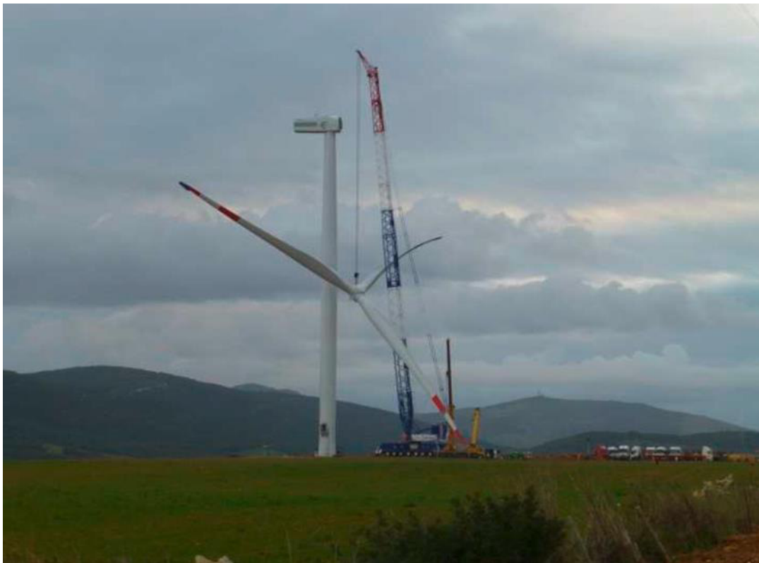
Figura 4_Montaggio aerogeneratore
