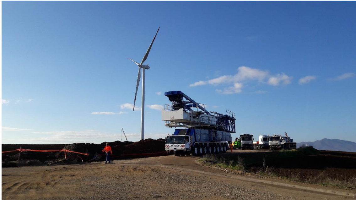
Figura 10_Esempio trasporto gru principale e mezzi di supporto - Parco eolico di Proprietà - Basilicata
