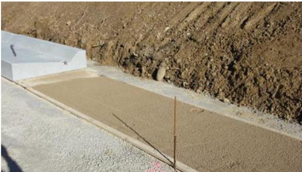
Figura 11\_cunetta di scolo acque meteoriche in cls in fase di realizzazione
