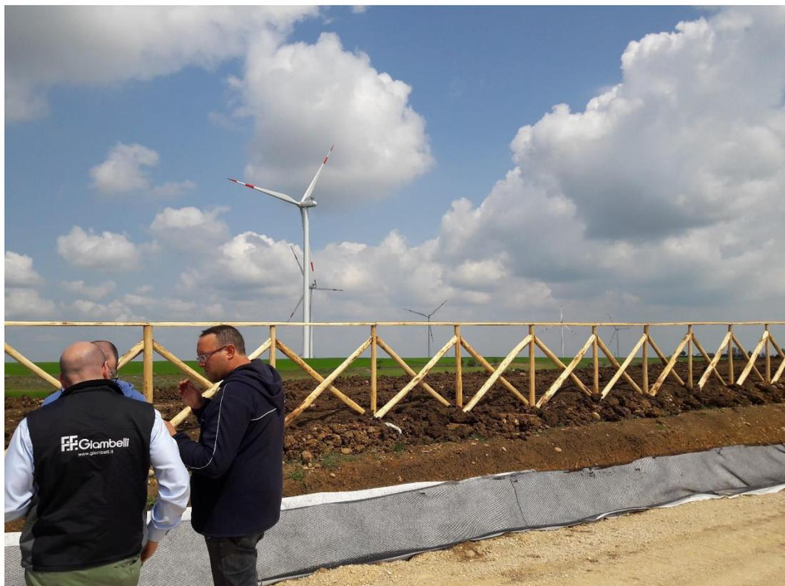
Figura 7\_ realizzazione cunetta con geotessuto e geogriglia per la gestione di ampi flussi (fase intermedia)
