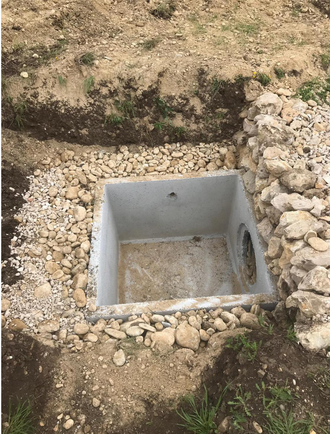
Figura 9\_ realizzazione tombino di raccordo tra tubazione armco e cunette (fase intermedia). L'opera sarà interamente rivestita con geotessuto e geoglia di rinforzo, dotata di canalizzatori in cls e debitamente ancorata al terreno
