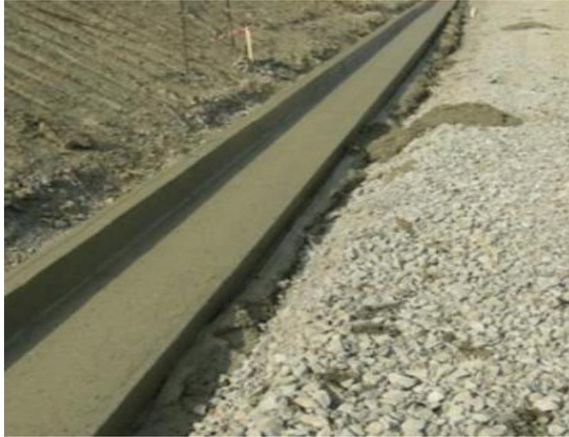
Figura 12\_cunetta di scolo acque meteoriche in cls in fase di realizzazione
