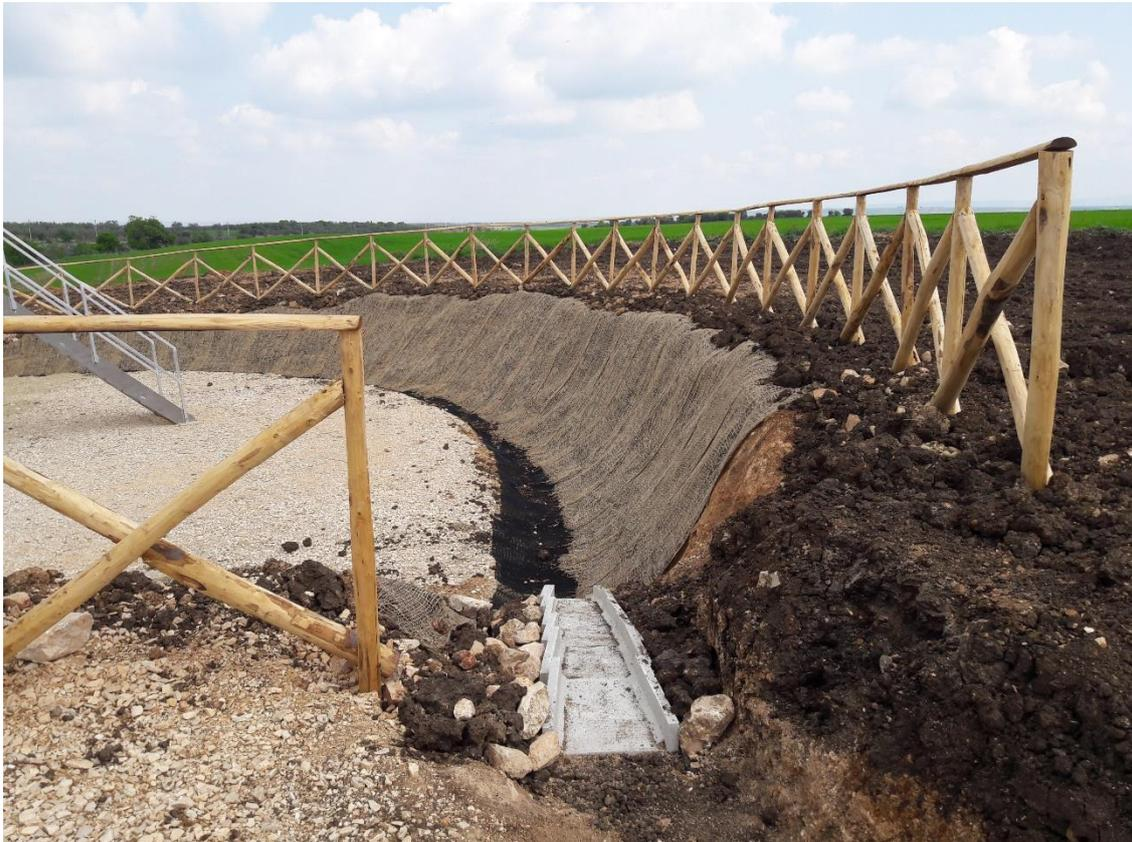
Figura 5 \_realizzazione cunetta con materiale antiscivolo e porzione cunetta in cls prefabbricato
