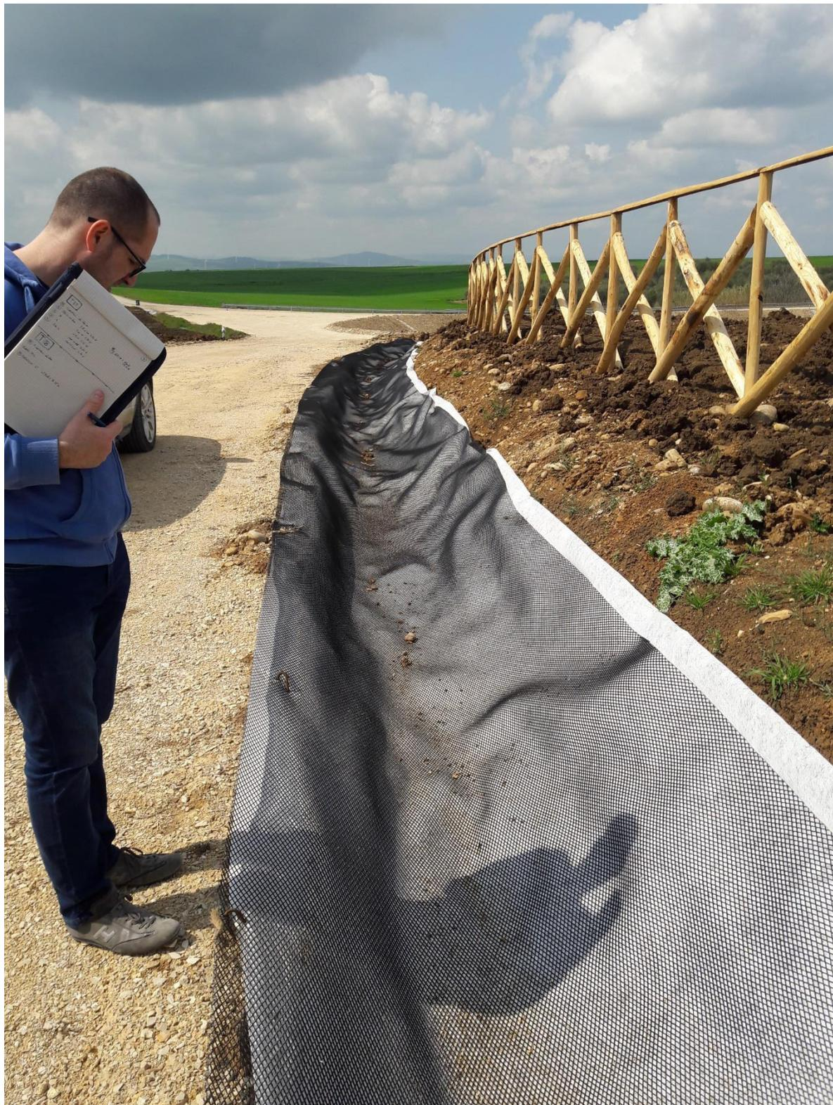
Figura 6 \_realizzazione cunetta con geotessuto e geogriglia per la gestione di ampi flussi(fase intermedia)
