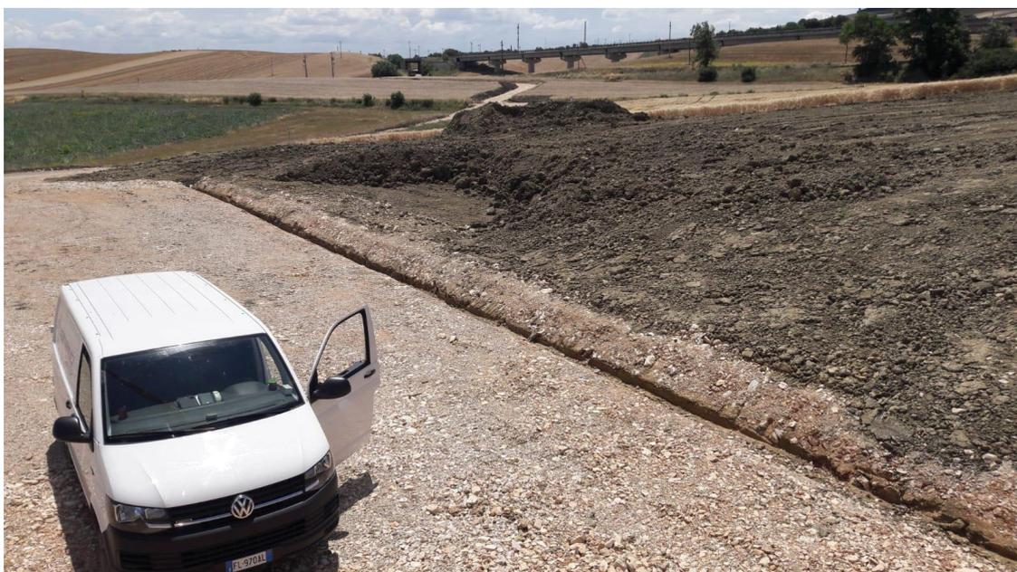
Figura 8\_ realizzazione cunetta in terra e misto stabilizzato per la raccolta delle acque di versante
