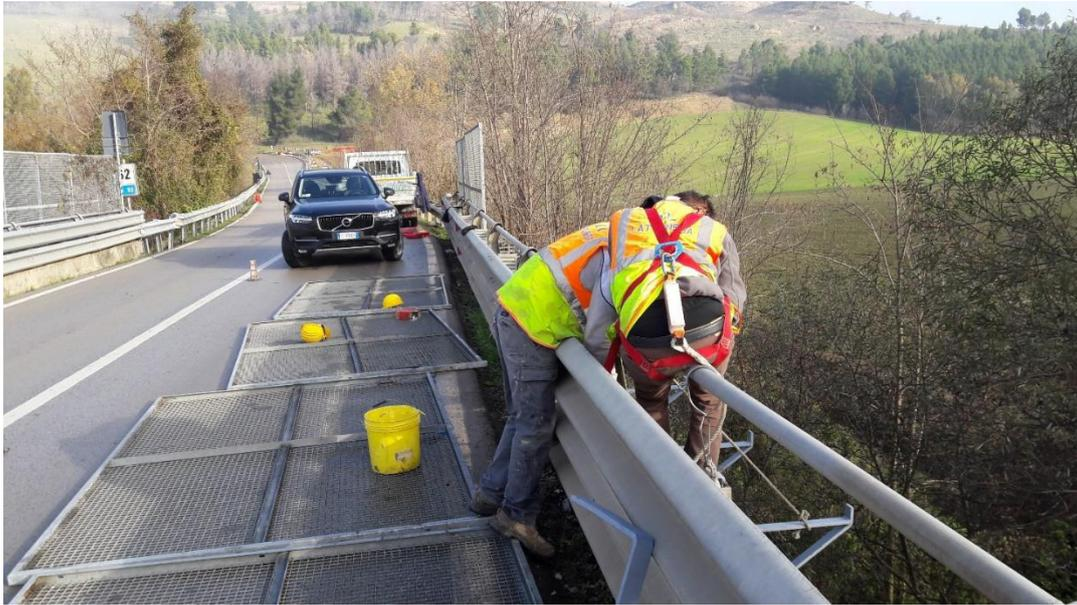
Figura 12\_ Sostituzione canaline esterne ammalorate – Impianto Eolico di Proprietà – Basilicata
