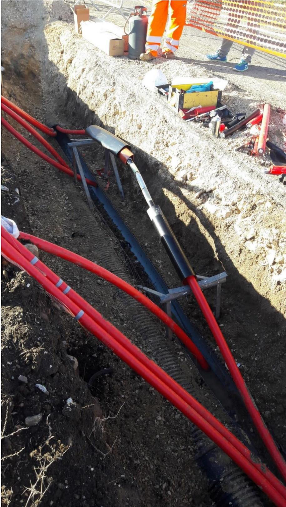
Figura 8\_ Individuazione e sostituzione giunto (giunto a caldo) – Impianto Eolico di Proprietà – Basilicata
