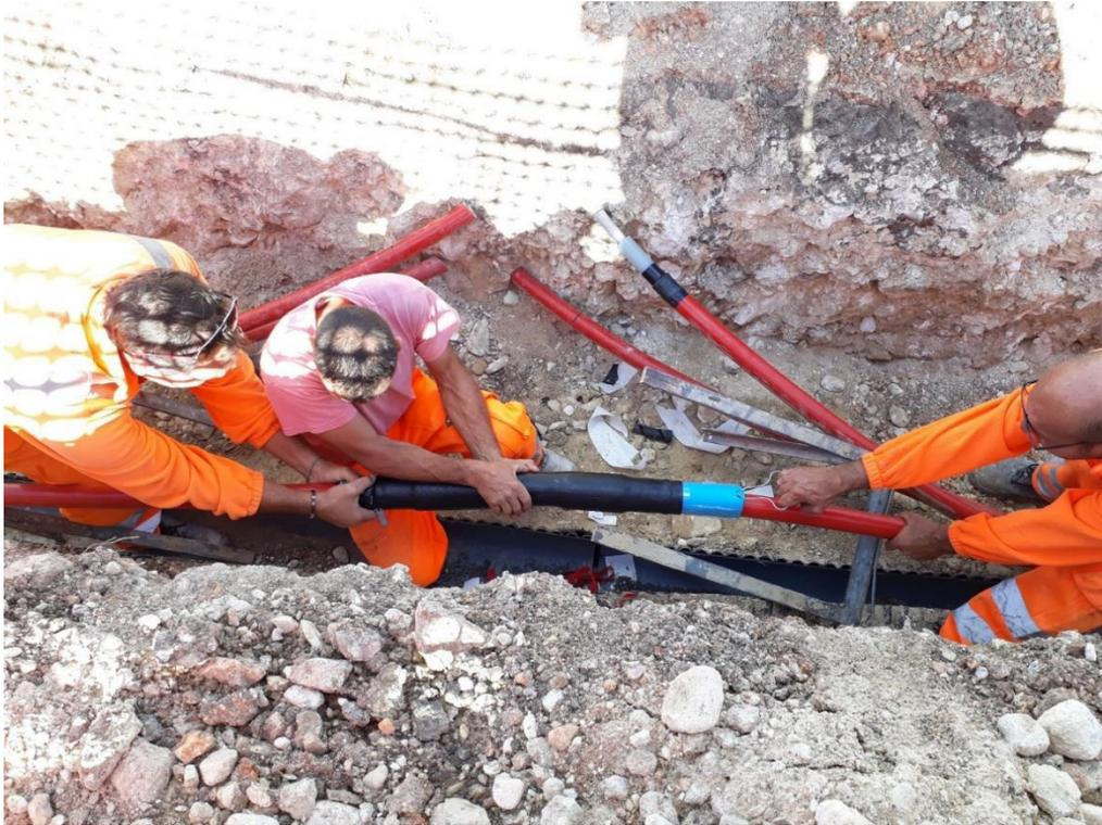
Figura 7\_ Individuazione e sostituzione giunto (giunti a freddo) – Parco Eolico di proprietà - Puglia
