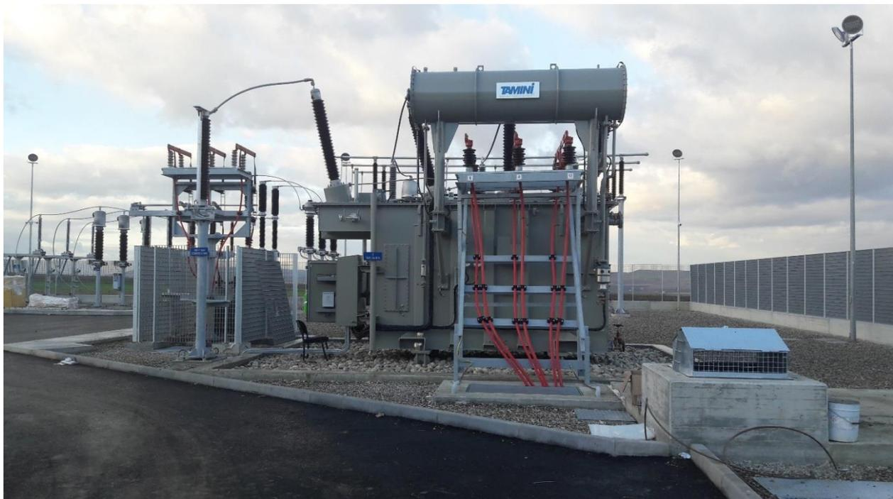
Figura 5\_ Trasformatore MT/AT Parco Eolico di Proprietà (S.E. Melfi)
