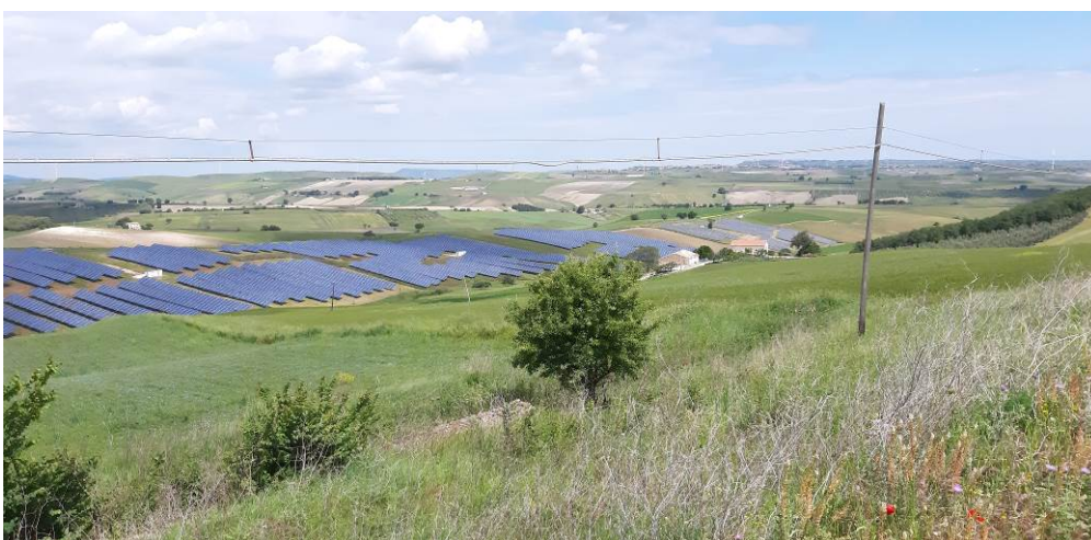
Figura 15: uno degli impianti fotovoltaici presenti nell'agro di Rotello
