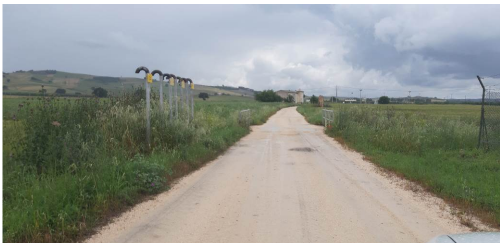
Figura 17: le immagini sono rappresentative delle strade presenti nell'area della SE 380 kV, interessate da molteplici linee di trasporto di gas verso la centrale ENI
