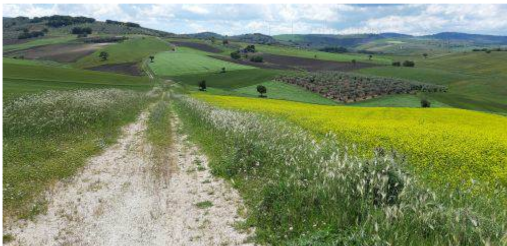
Figura 12 – vista dell'area di impianto in prossimità della WTG A06
