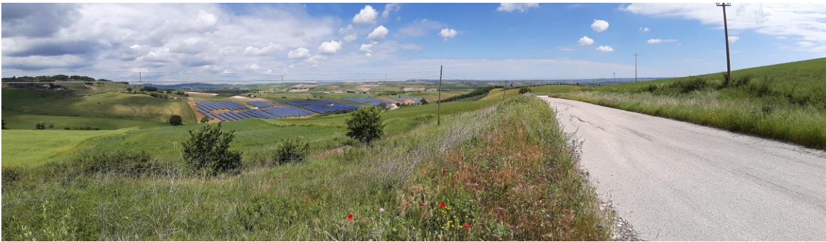
Foto 7 – Strada interessata all'intervento evidenza impianti in zona
