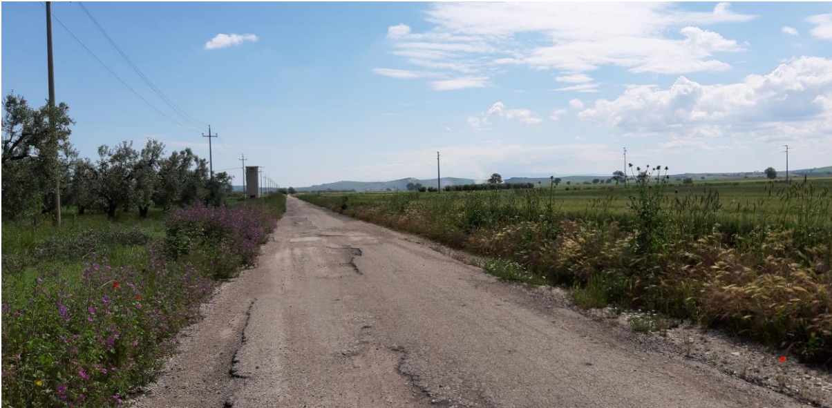
Foto 8 – Sito di installazione aerogeneratore 10 e 11
