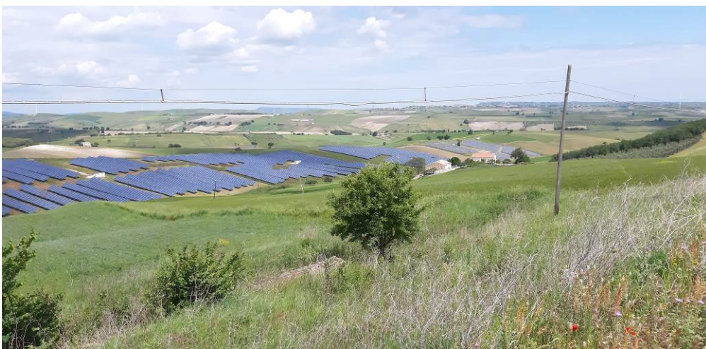
Figura 9: uno degli impianti fotovoltaici presenti nell'agro di Rotello
