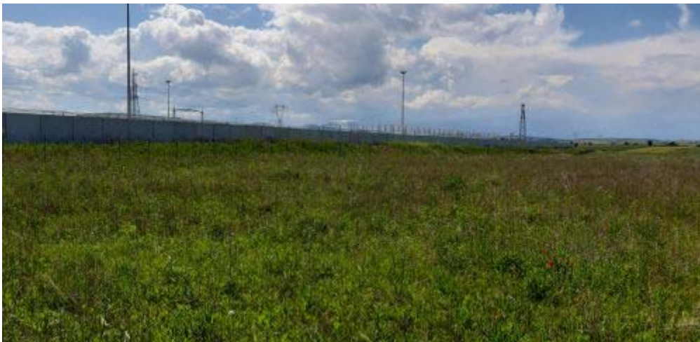
Figura 8 – viste dell'area di sottostazione in adiacenza alla stazione elettrica 380kV "Rotello".
