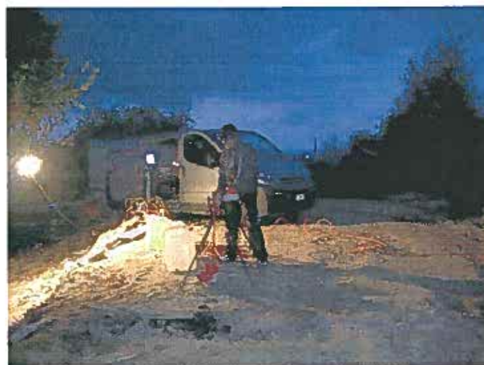
Figura 13: Acquisizione dati cross-hole ACCH1501-ACCH2502 onde P (località Cannitello)
