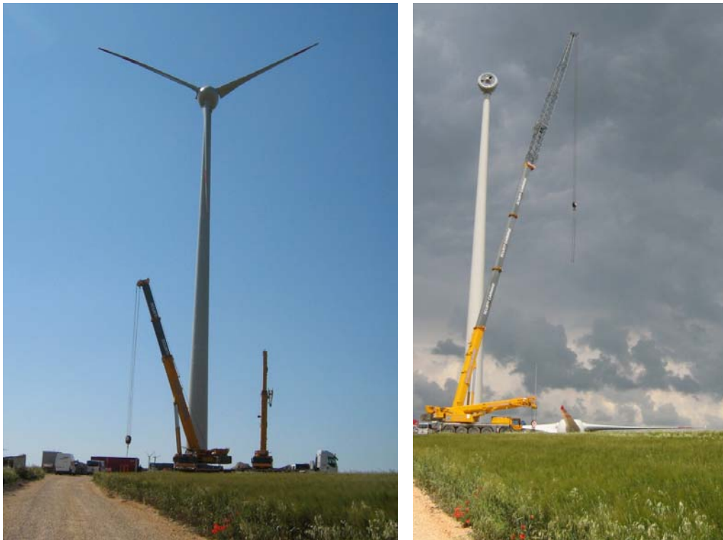
Figura 2: rimozione eliche e mozzo
