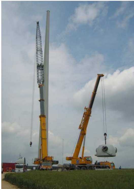
Figura 3: smontaggio navicella
