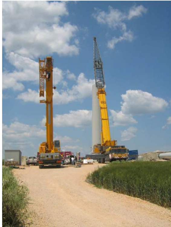
Figura 4: particolare smontaggio torre
