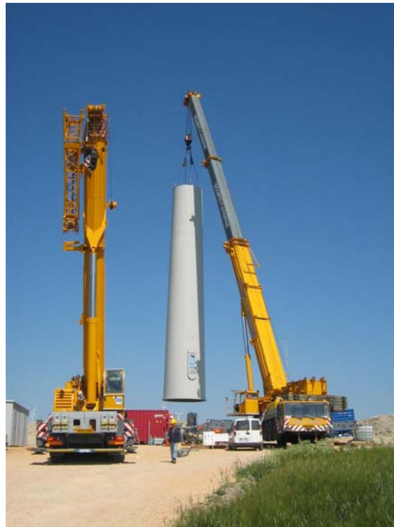
Figura 5: elemento torre smontata da trasportare
