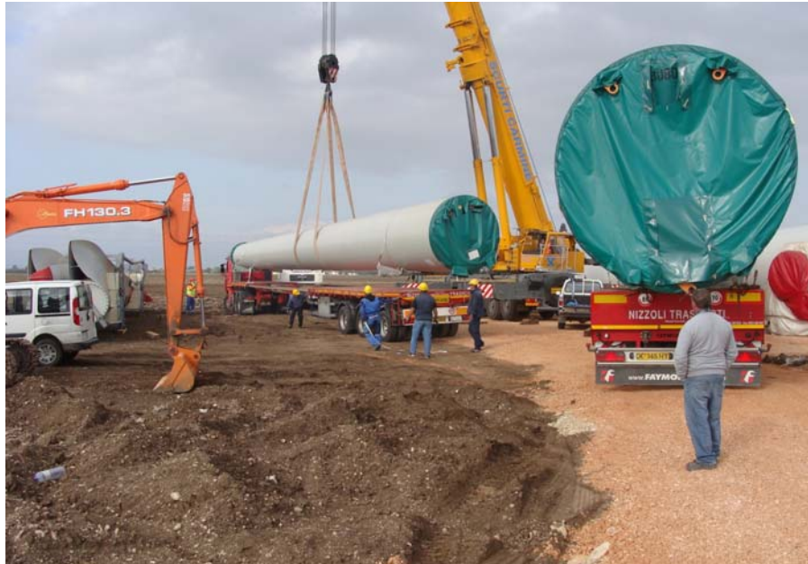
Figura 6: elementi torre smontata da trasportare
