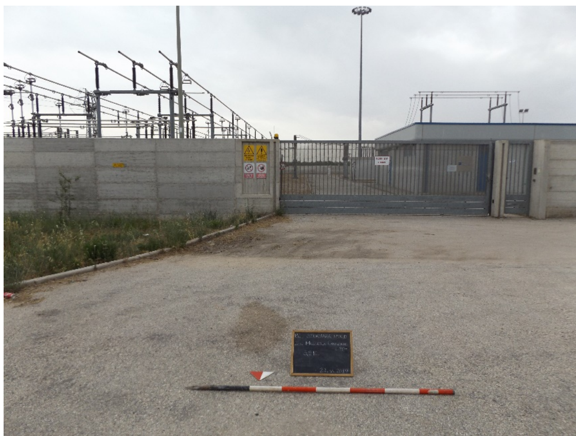
Foto 1: Area della SSE del progetto Stornara Nord
