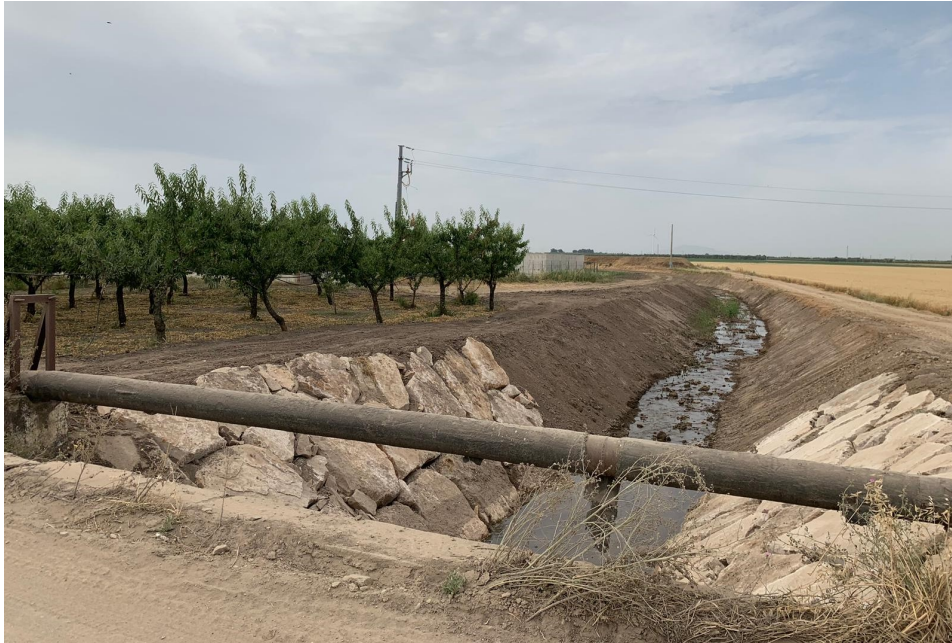
Corsi acqua Marana La Pidocchiosa ( lungo tratto di attraversamento del cavidotto)
