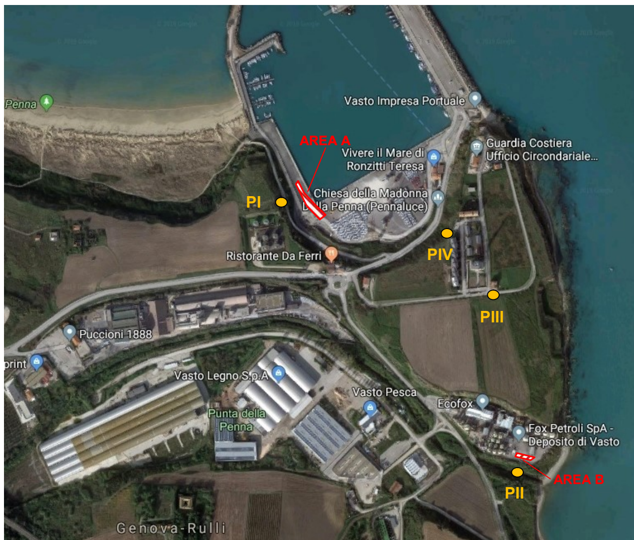
Vista aerea ubicazione cantiere “A” e “B” e ubicazione dei ricettori ipotizzati PI-PII-PIII-PIV
