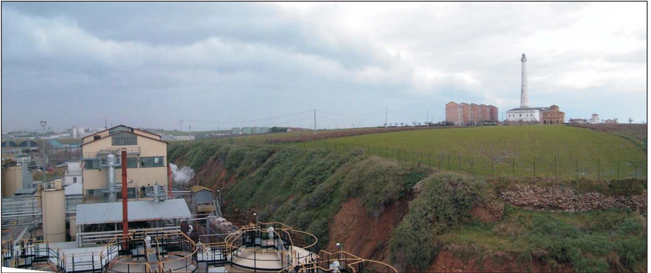
FOTO 1 - PANORAMICA DELLA SCARPATA A MONTE DELLO STABILIMENTO ECOFOX - VASTO
