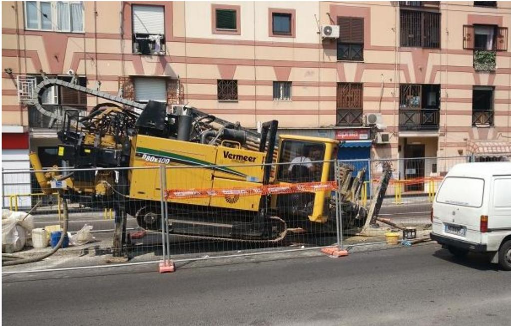
*Figura 6-11 Esempio di macchina operatrice per esecuzione TOC*
