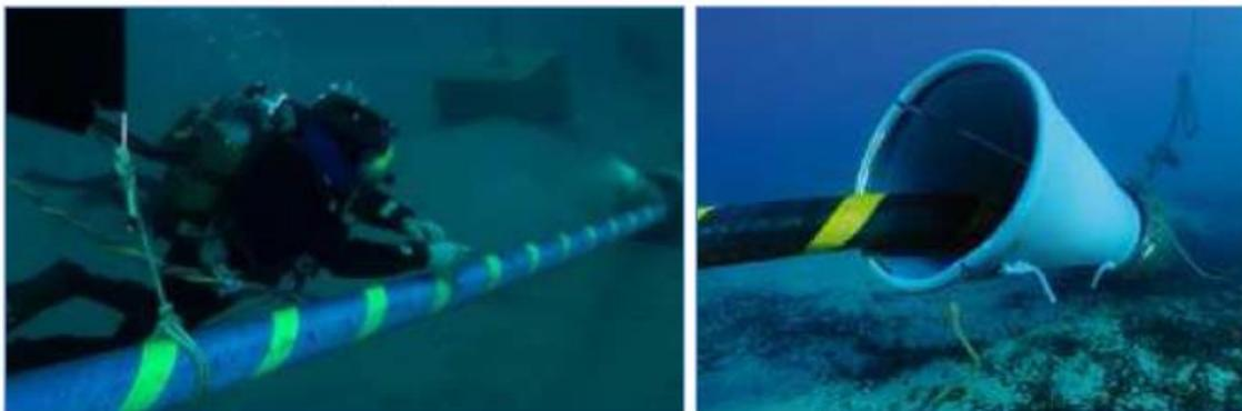
Figura 6-21 Tipico di un tiro del cavo all'interno della tubazione in PEAD all'approdo
