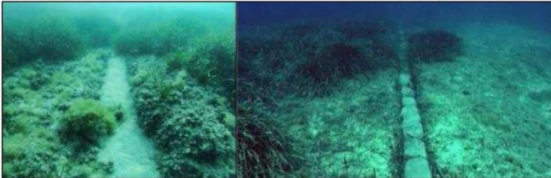
*Figura 6-29 Trincee su Posidonia su sabbia realizzate mediante jetting*
