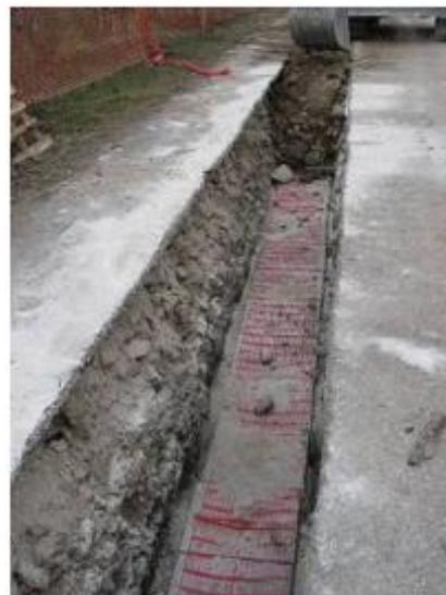
Figura 6-7 Esempio di rinterro con posa delle piastre di protezione e rete in PVC
