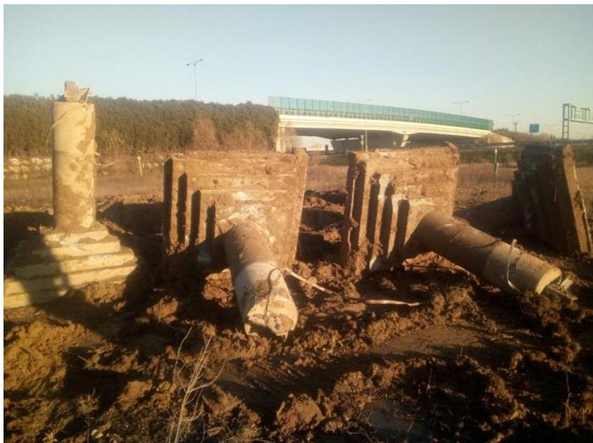
*Figura 6-43 Esempio di rimozione della fondazione superficiale di un sostegno 220 kV*
