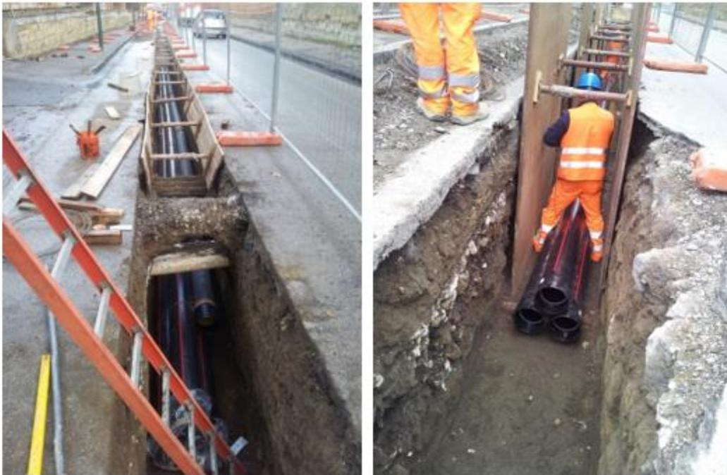
*Figura 6-3 Esempio di posa in tubiera con relative sbatacchiature eseguite su strada*
