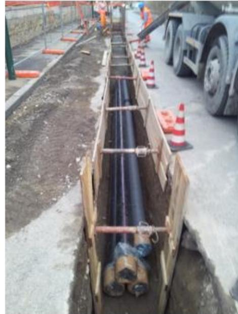
Figura 6-8 Esempio di rinterro con posa delle tubiere
