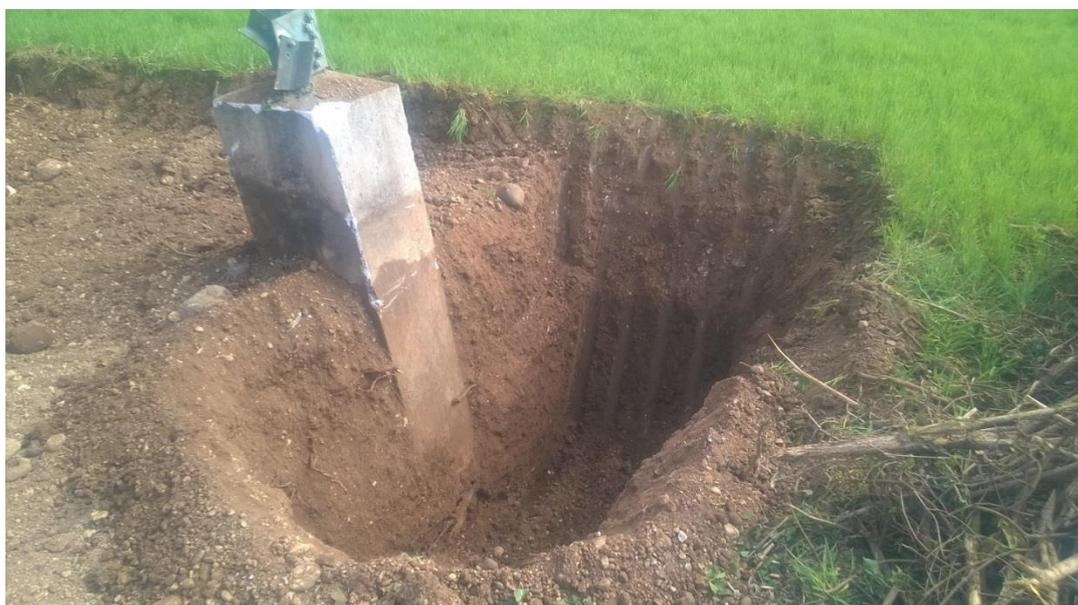
*Figura 6-44 Esempio rimozione della fondazione superficiale di un sostegno 380 kV ST*
