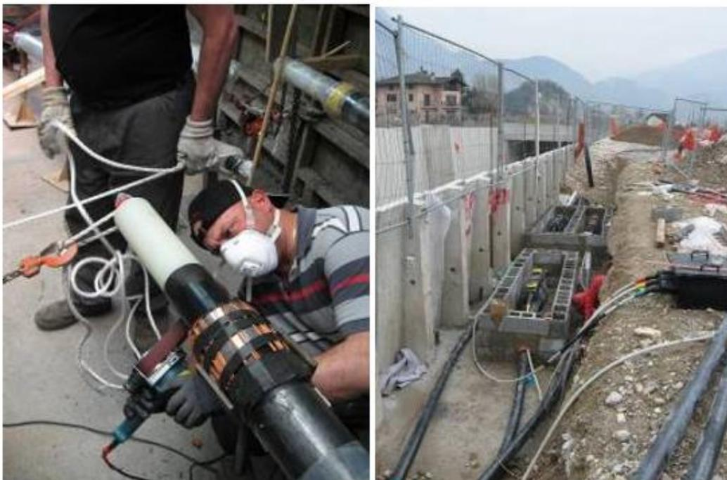
Figura 6-14 Esempio di esecuzione di un giunto e di una buca giunti
