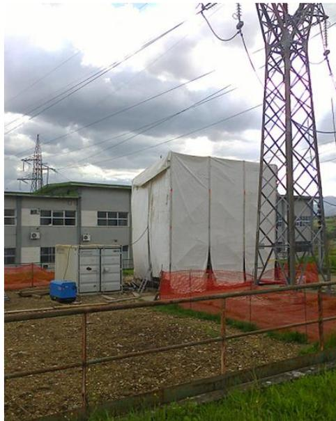
*Figura 6-15 Esempio di realizzazione di elementi terminali*
