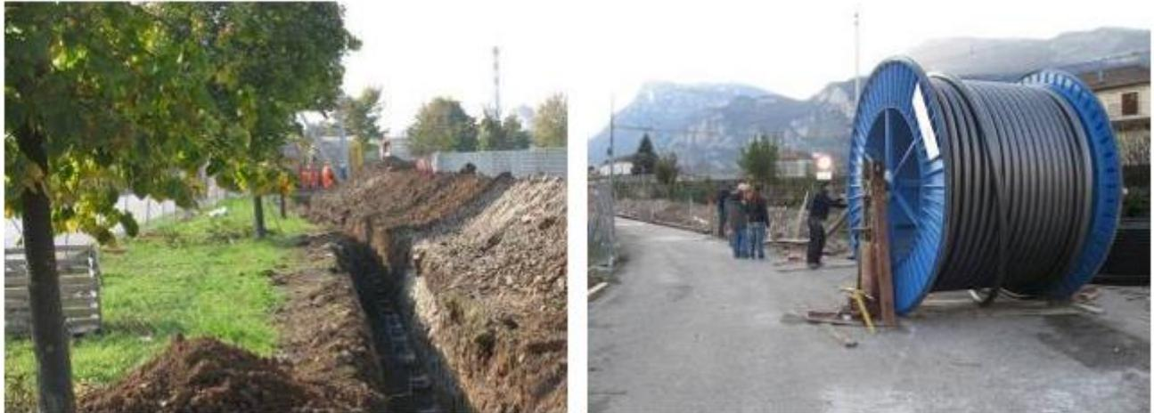
Figura 6-6 Esempi di posizionamento della bobina contenente il cavo
