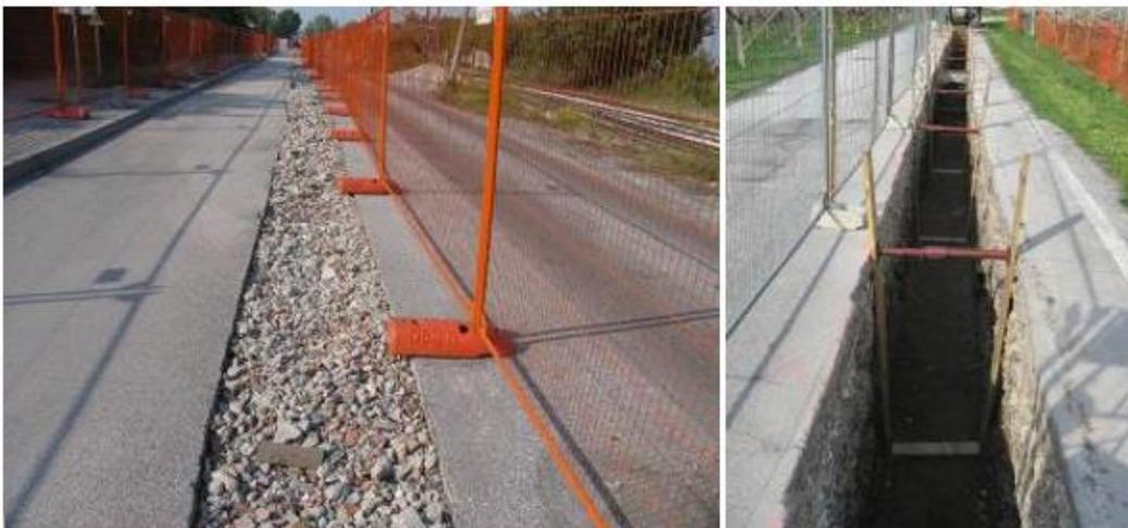
Figura 6-5 Esempi di posa a cielo aperto con taglio dell'asfaltatura
