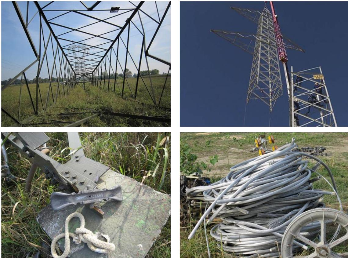
Figura 6-42 Esempio demolizione di un sostegno a traliccio e particolare dei materiali raccolti per il recupero
