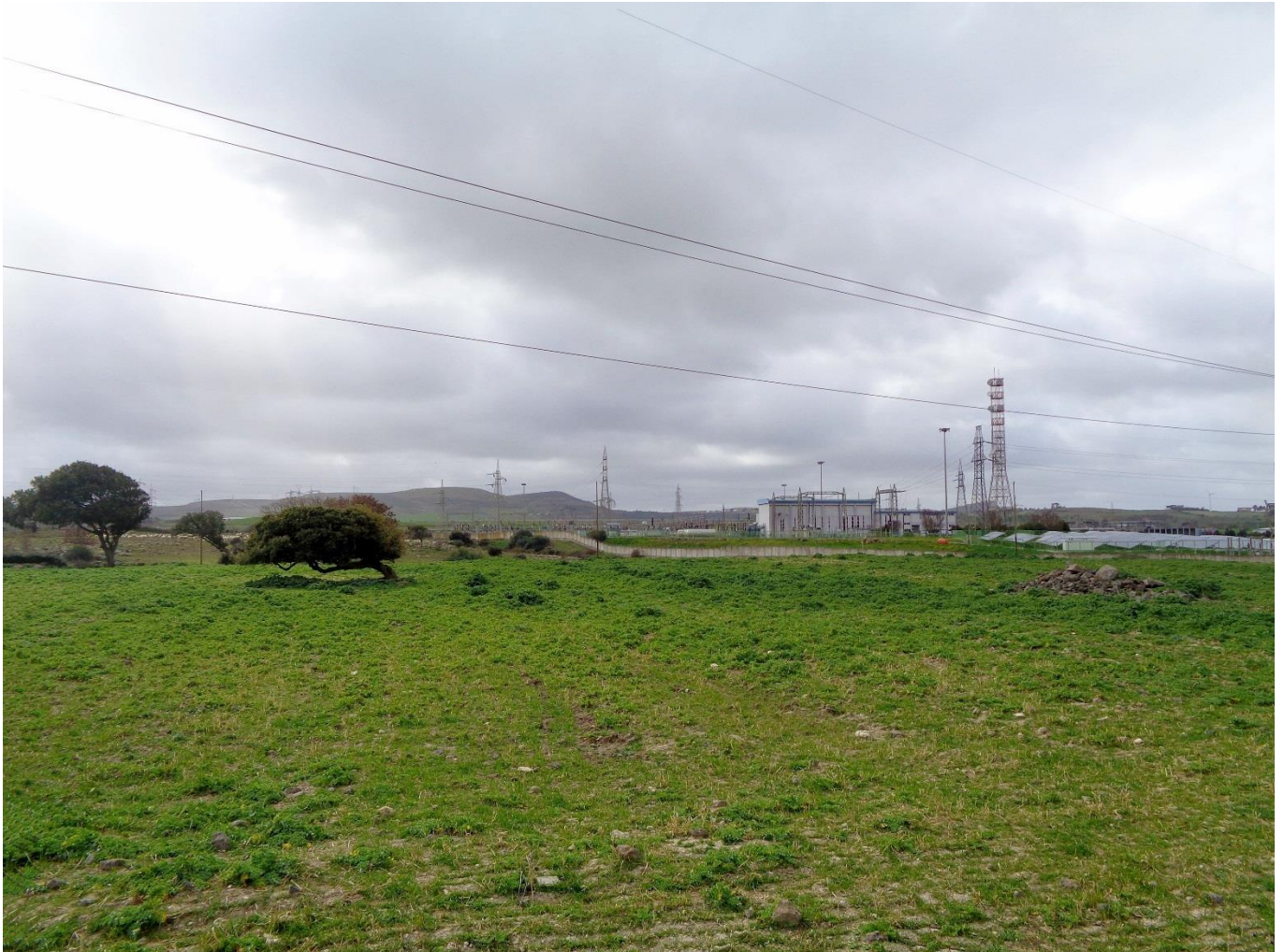
Figura 4-139 - Ante operam Intervento A Punto B
