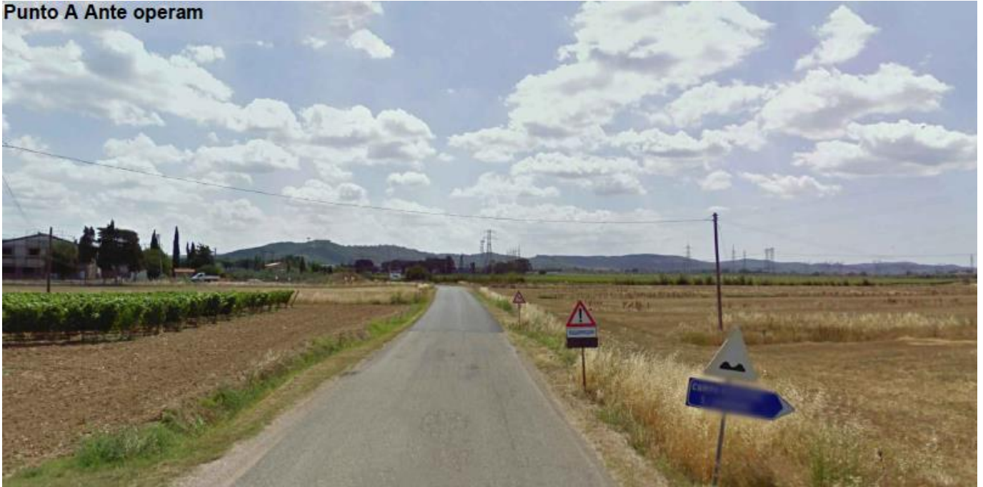
Figura 4-142 - Ante operam Intervento F Punto A
