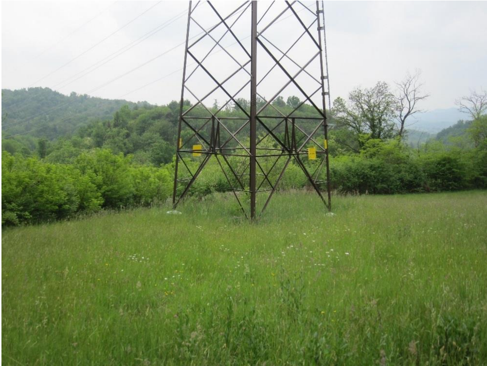
Figura 7-3 Esempio di intervento di inerbimento sulle linee 132 kV della Val D'Ossola Sud
