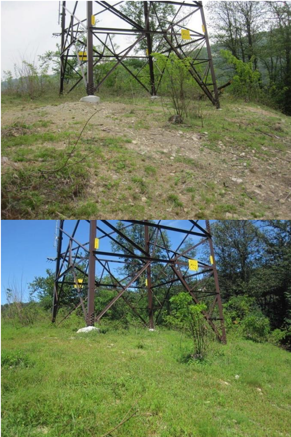
Figura 7-5 Esempio di interventi di rinaturazione ante (sopra) e post operam (sotto) sulle linee 132 kV della Val D'Ossola Sud
