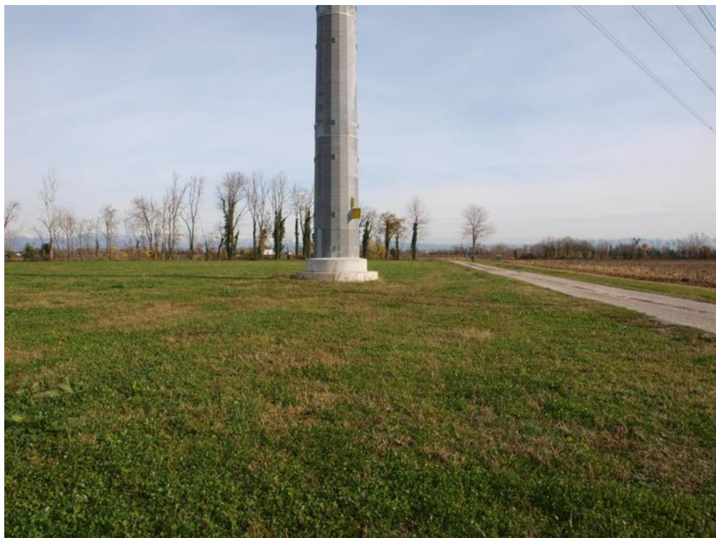
Figura 7-2 Esempio di intervento di ripristino a prato sulla linea 380 kV Udine Ovest – Udine Sud
