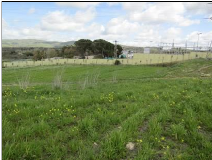
Area investigata, vista della centrale elettrica esistente
