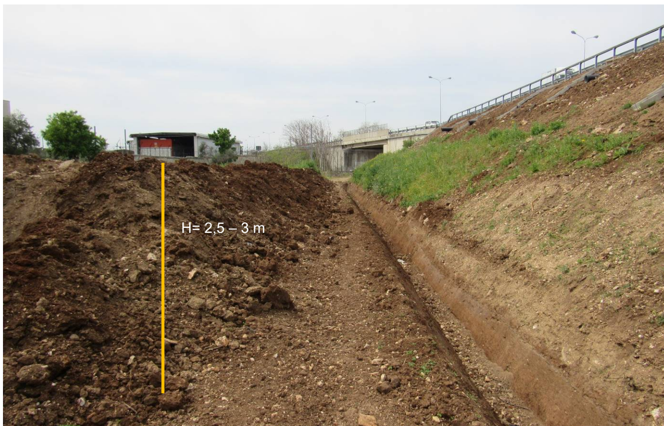
Figura 3-7 Veduta margine del Deposito B
