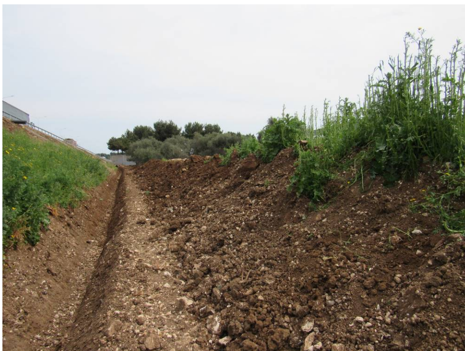
Figura 5-2 Aspetto del margine lato nuovo rilevato del deposito B
