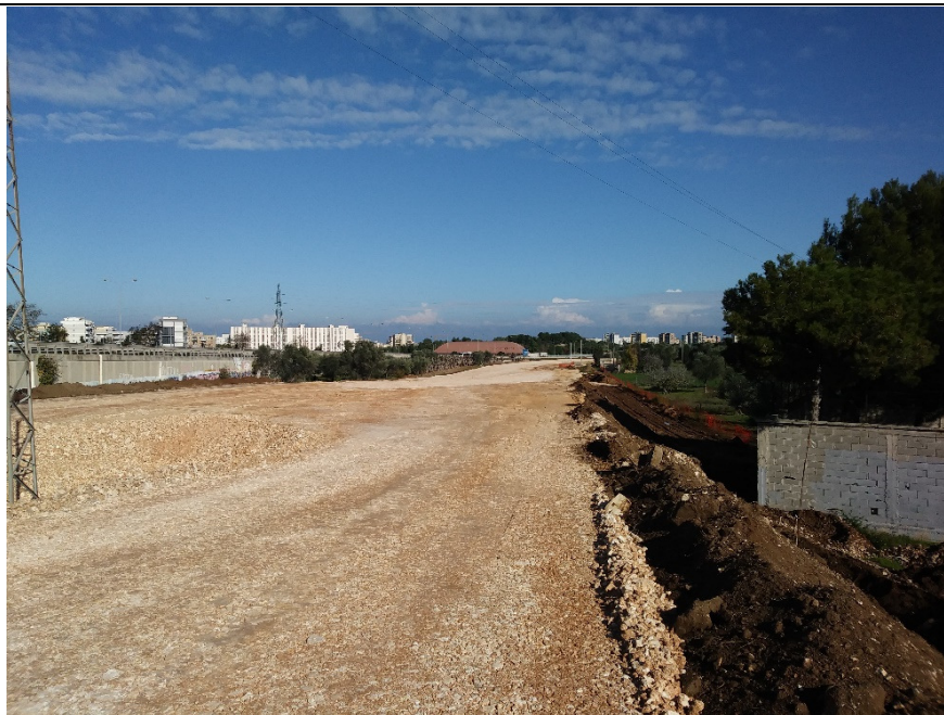
Foto Aree Lavorazioni – Realizzazione rilevato stradale
