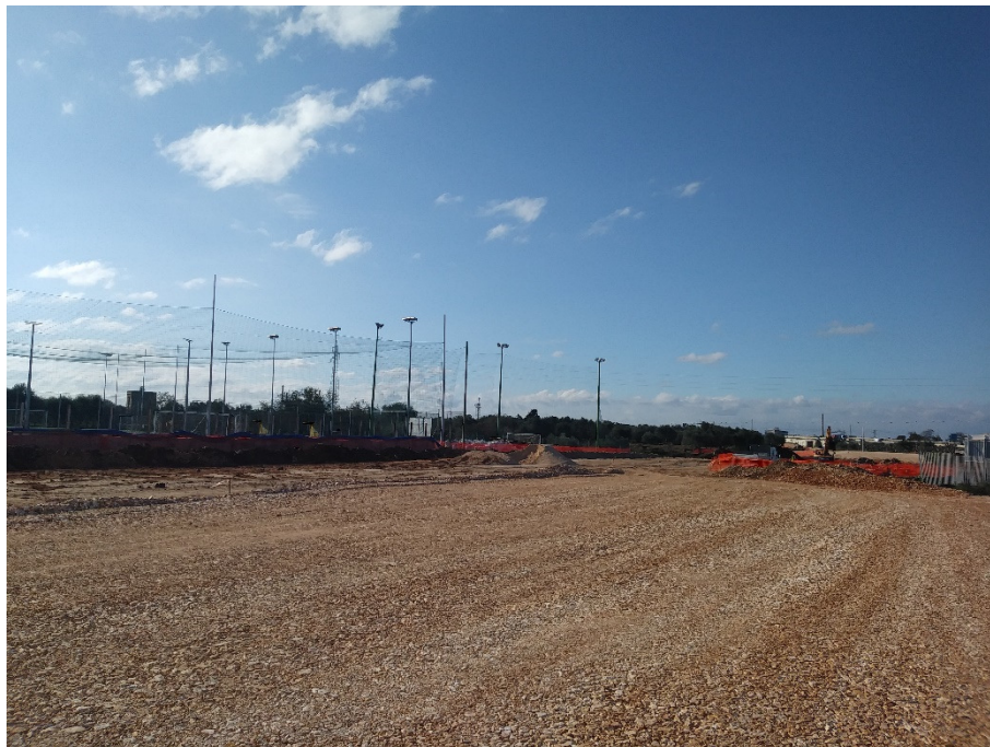
Foto Aree Lavorazioni – Realizzazione rilevato stradale
