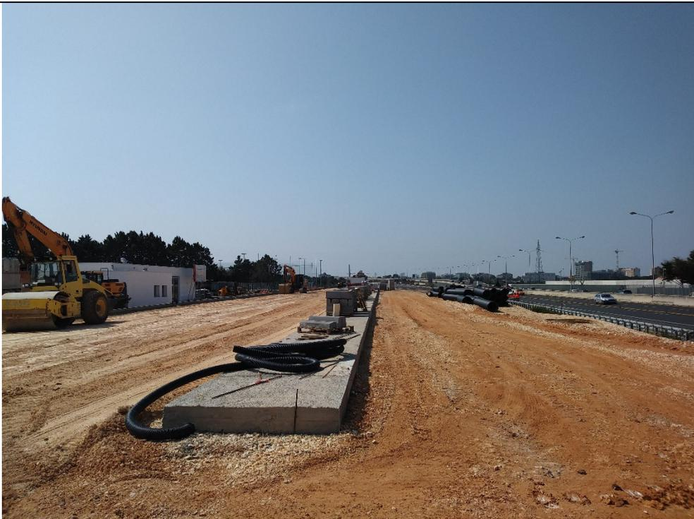
Foto Aree Lavorazioni – Ultimazione zona transizione vecchio/nuovo rilevato stradale
