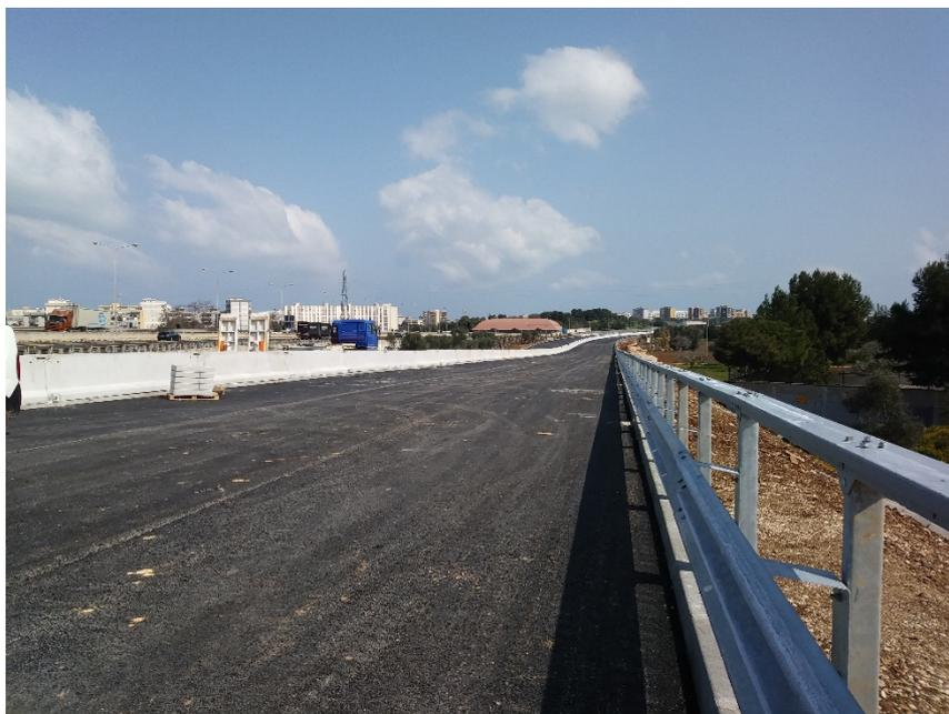
Foto Aree Lavorazioni – Ultimazione nuovo rilevato stradale
