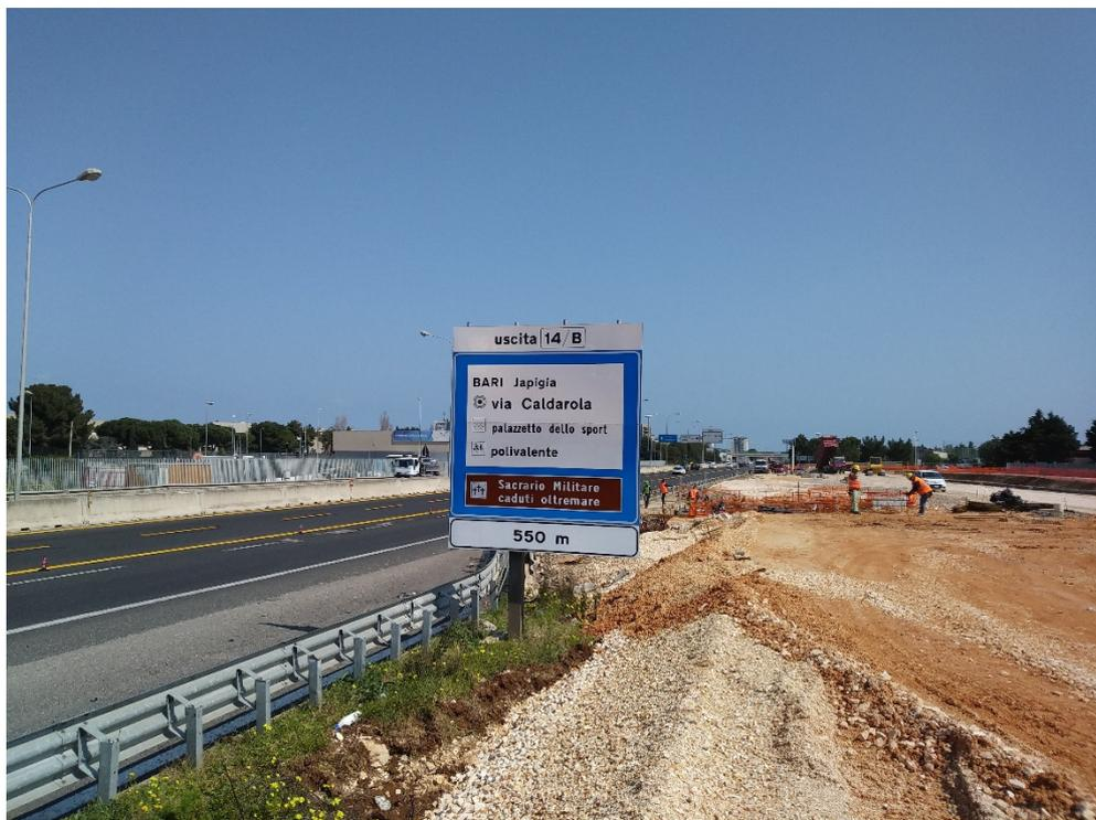
Foto Aree Lavorazioni – Realizzazione nuovo rilevato stradale
