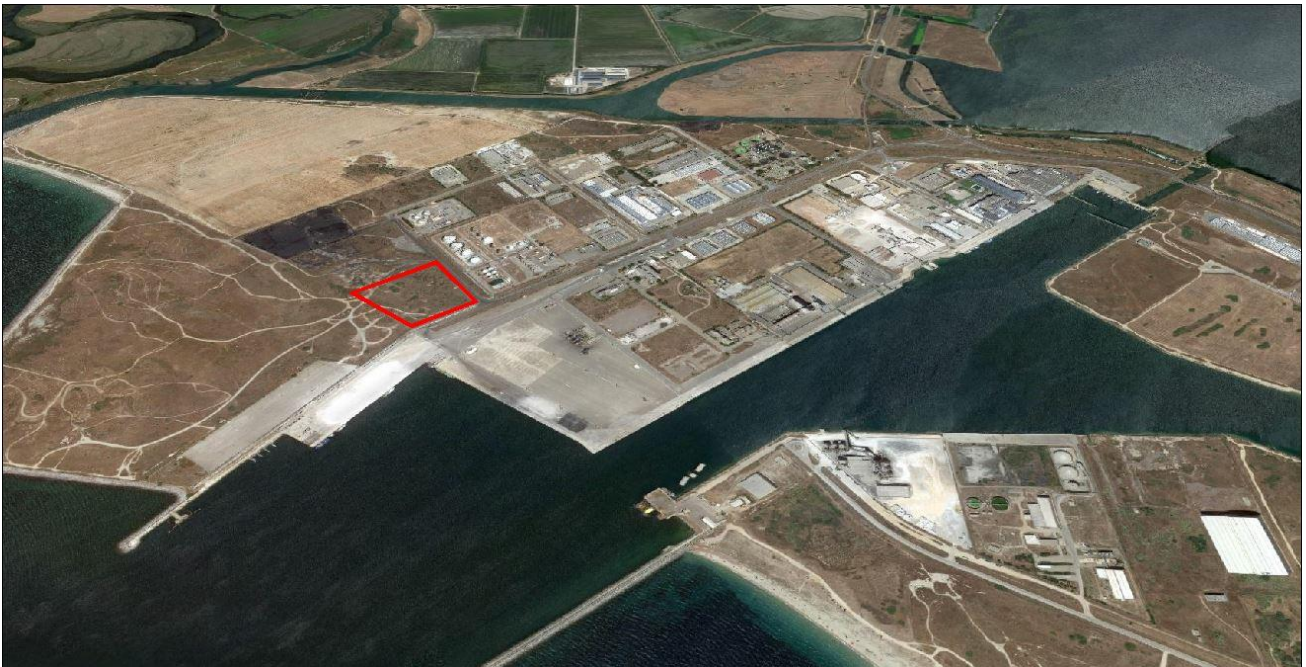
Vista aerea dell'Area di Intervento – Verso Nord Est
